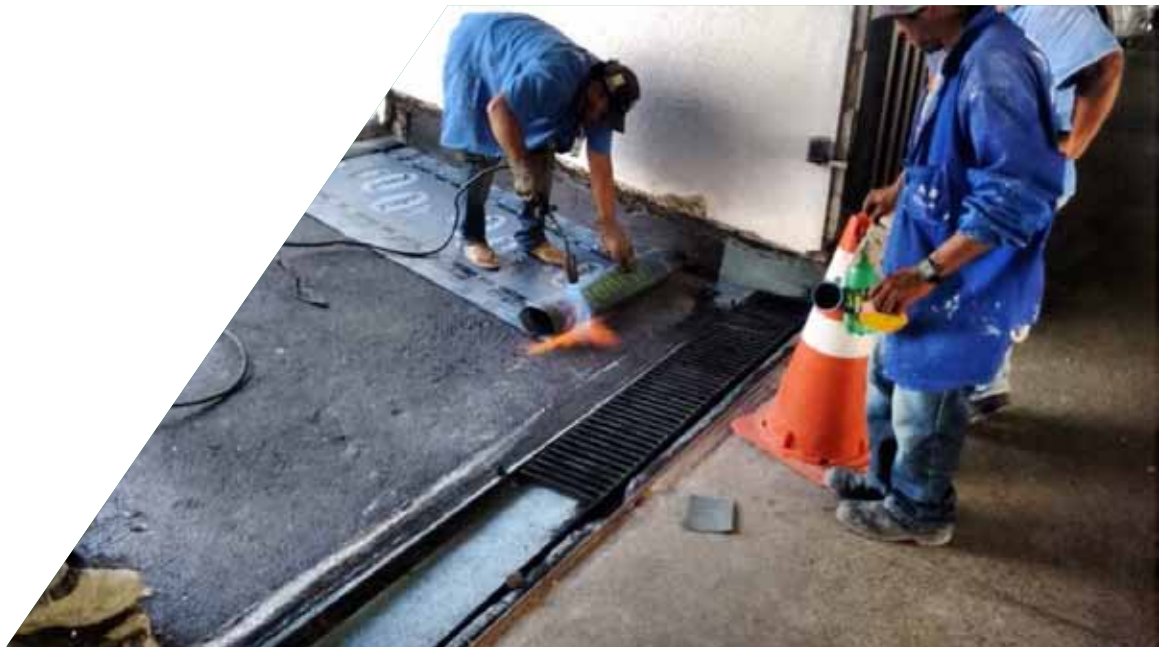
No Anexo II, foram recuperadas uma viga e parte da laje da rampa de entrada de veículos do subsolo
