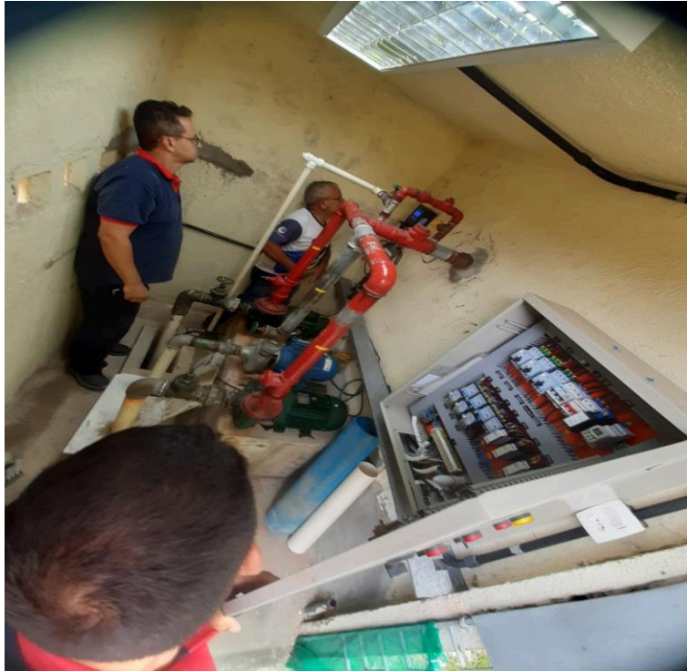
Foto 03 – Instalação de Quadro de Comando
