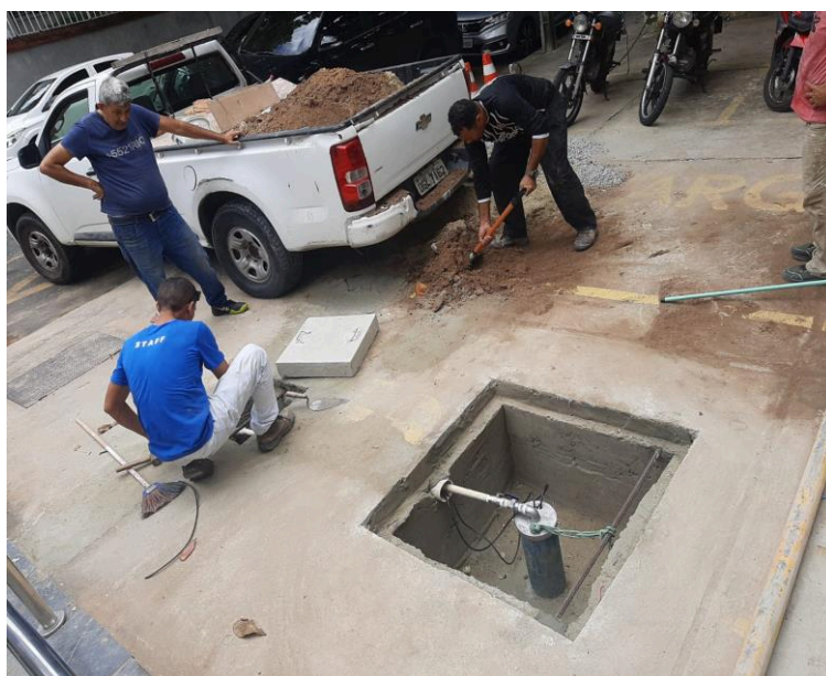
Foto 06 – Colocação da Máquina e Tapume
