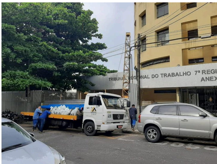
Foto 01 – Retirada de entulho da Obra
