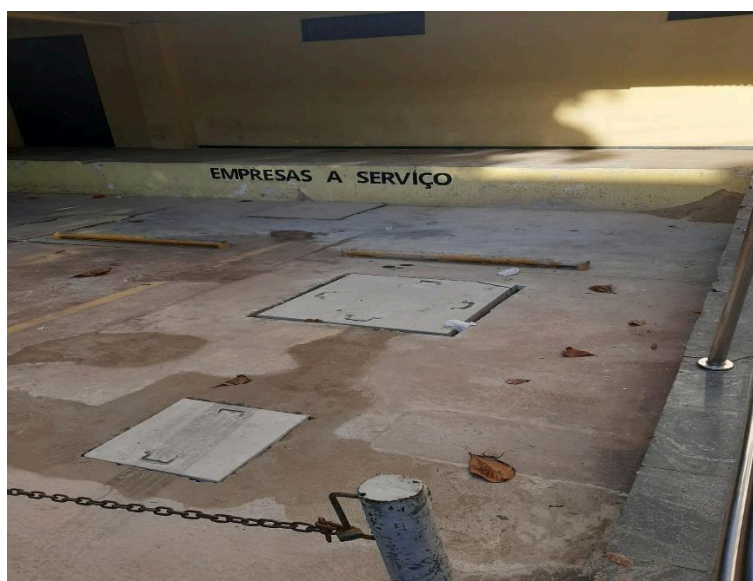
Foto 02 – Piso devidamente recuperado e colocação tampas
