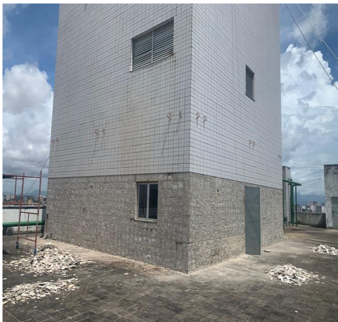
REMOÇÃO DO REVESTIMENTO DA EXTENSÃO DA CAIXA D' ÁGUA
