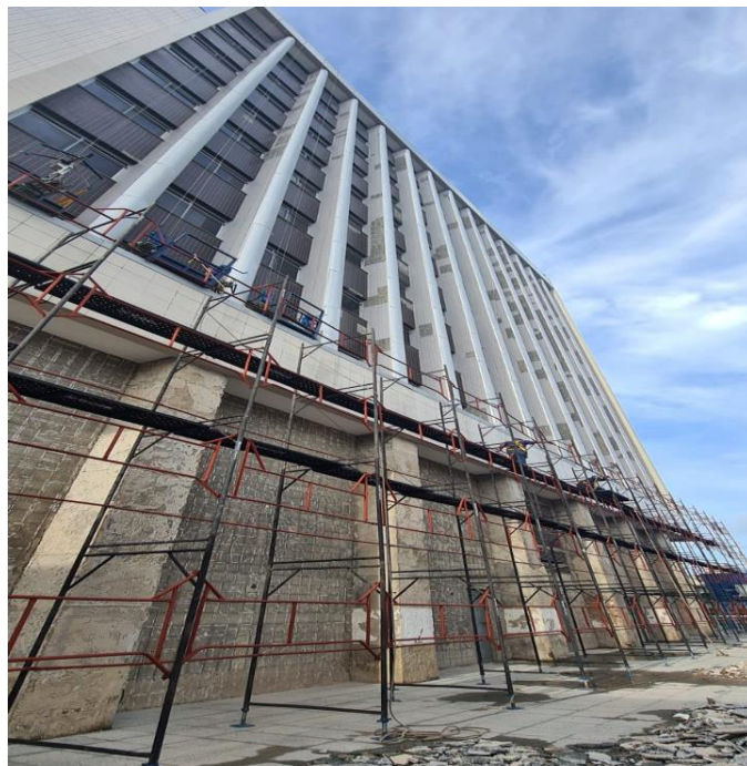
MONTAGEM DE ANDAIME FACHADEIRO DA FACHADA SUL
