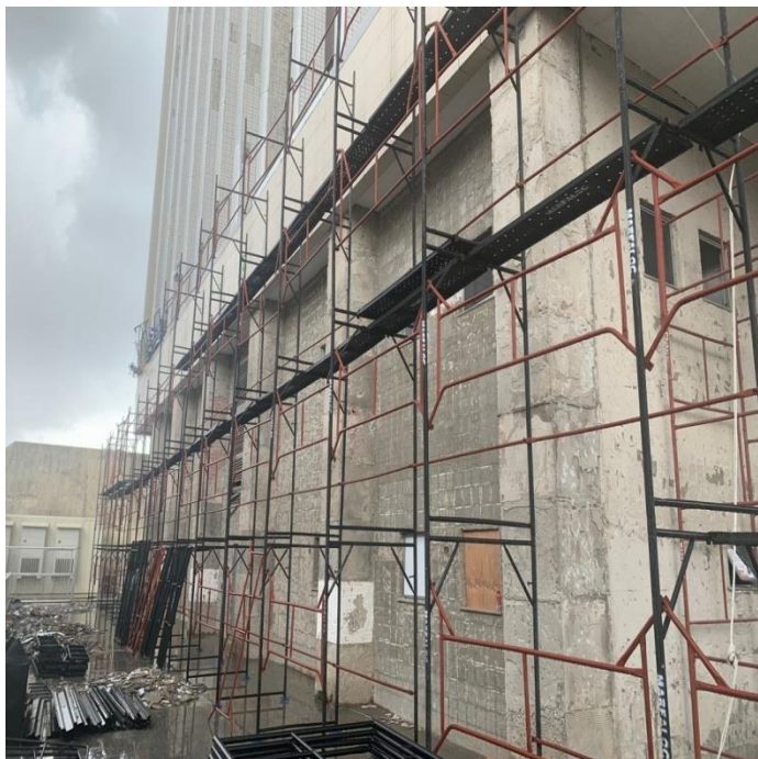
MONTAGEM DE ANDAIME FACHADEIRO DA FACHADA SUL
