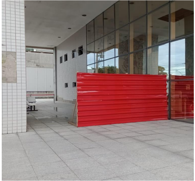
MONTAGEM DO TAPUME AO LADO DA RAMPA DE ACESSIBILIDADE
