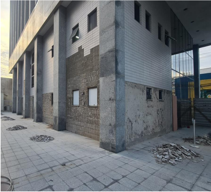
REMOÇÃO DO REVESTIMENTO DA FACHADA SUL E LESTE
