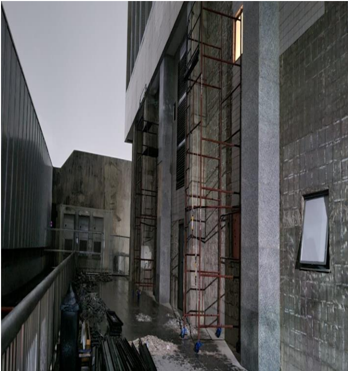
REMOÇÃO DO REVESTIMENTO DA FACHADA SUL
