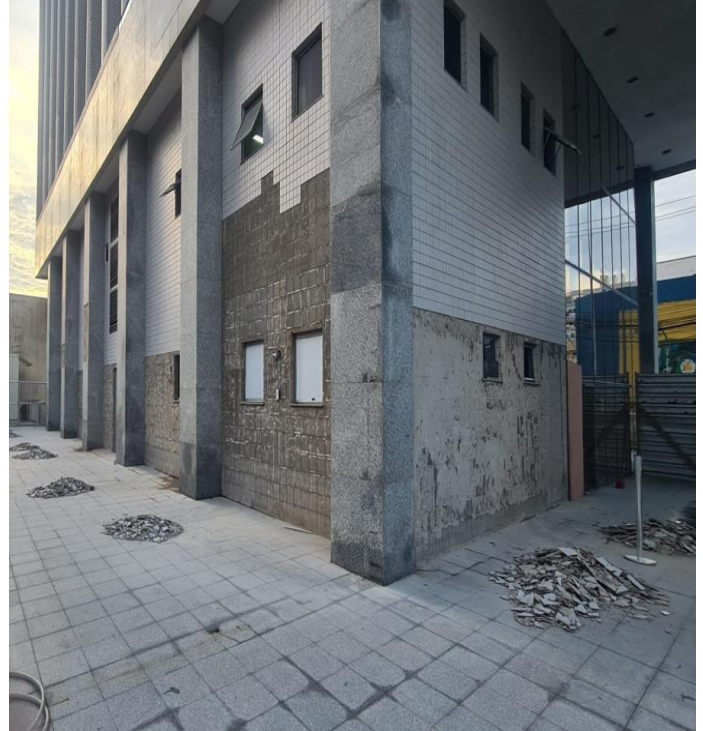
REMOÇÃO DO REVESTIMENTO DA FACHADA SUL E LESTE
