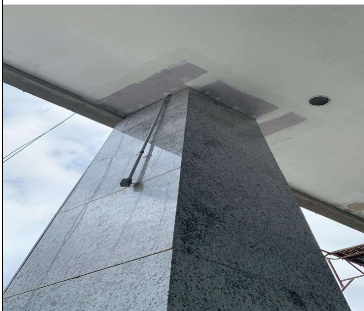
REVESTIMENTO DE GRANITO EM PILAR
