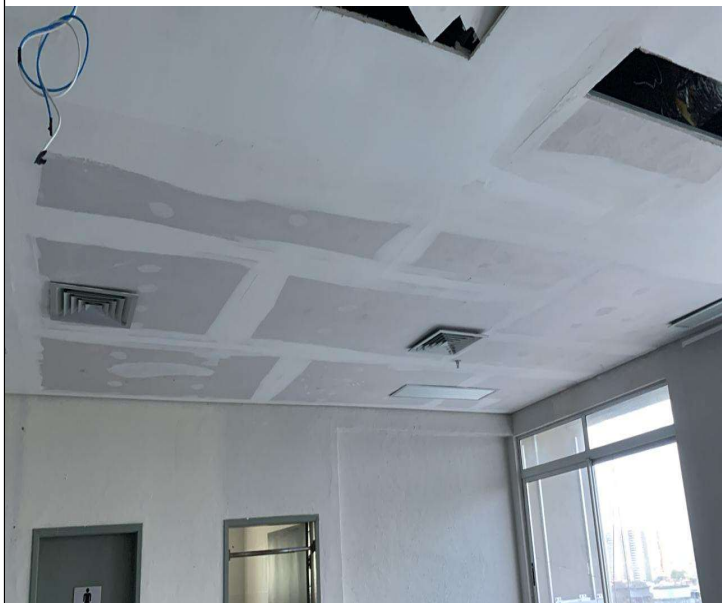
FORRO DE GESSO
