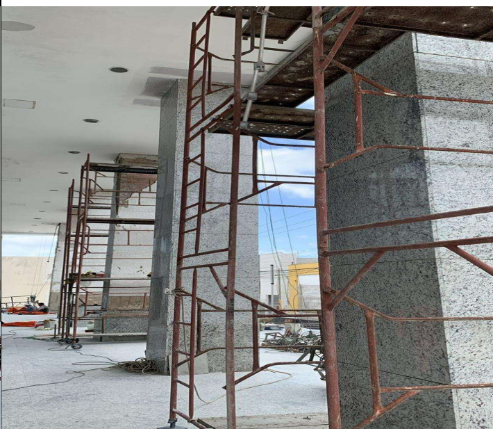
REVESTIMENTO DE GRANITO EM PILAR
