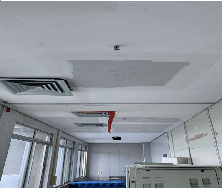
FORRO DE GESSO
