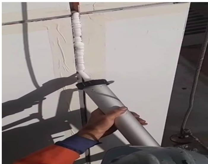
APLICAÇÃO DE SILICONE BRANCO NA FACHADA SUL
