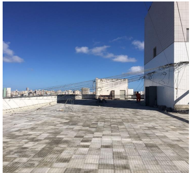
INSTALAÇÃO DE LADRILHO HIDRAULICO
