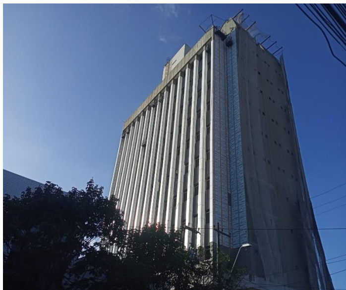
INSTALAÇÃO DA ESTRUTURA EM ACM DA FACHADA
