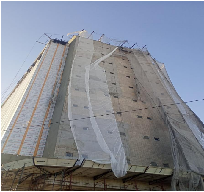
DEMOLIÇÃO DE REBOCO NA FACHADA SUL/LESTE
