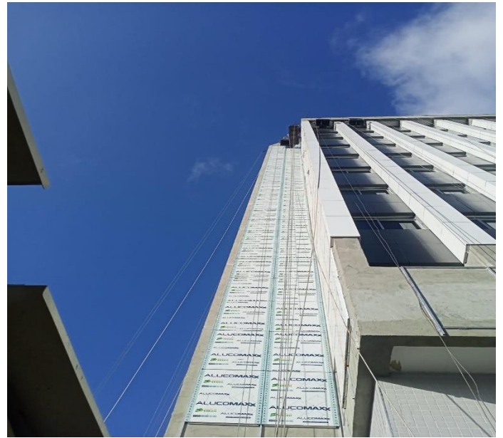
INSTALAÇÃO DA ESTRUTURA EM ACM NA FACHADA
