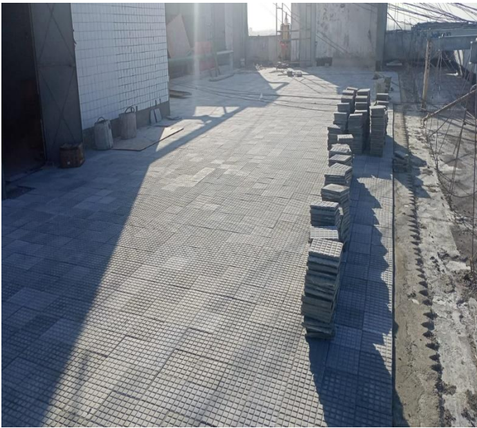
ASSENTAMENTO DO PISO EM LADRILHO HIDRÁULICO NA COBERTURA
