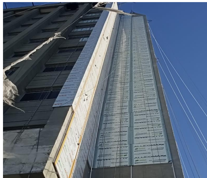
INSTALAÇÃO DA ESTRUTURA EM ACM DA FACHADA
