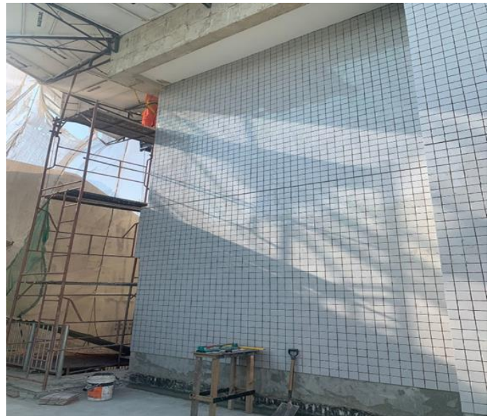
ASSENTAMENTO DO REVESTIMENTO DA FACHADA SUL
