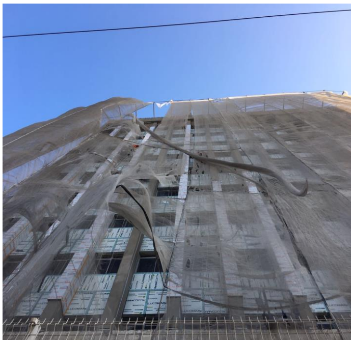
INSTALAÇÃO DA ESTRUTURA EM ACM NA FACHADA NORTE
