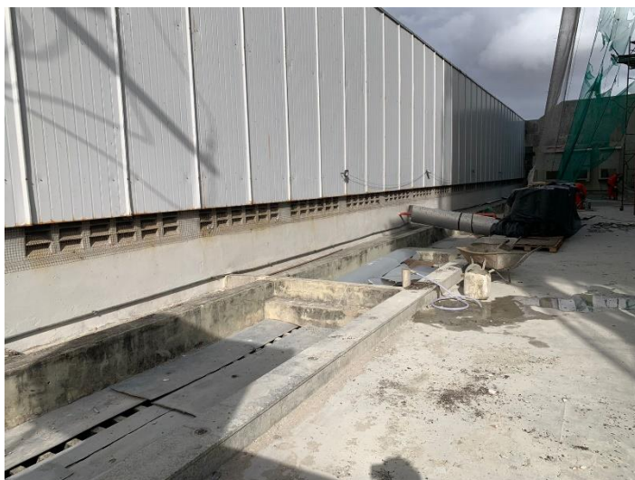
RETIRADA DE GUARDA CORPO EM ALUMÍNIO
