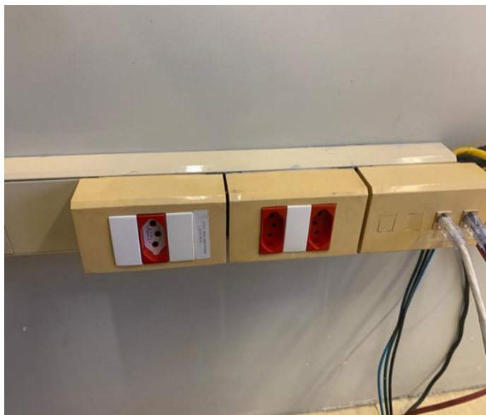
TROCA DE MODULOS DE TOMADAS DAS TOMADAS
