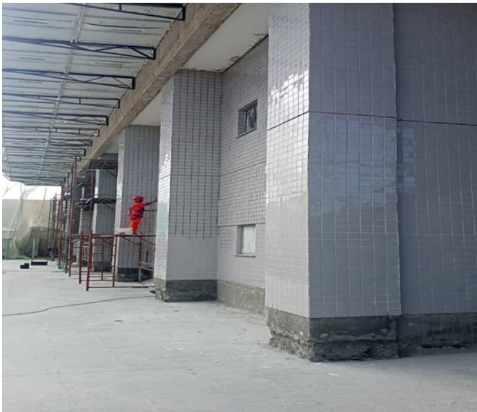
ASSENTAMENTO DO REVESTIMENTO DA FACHADA SUL
