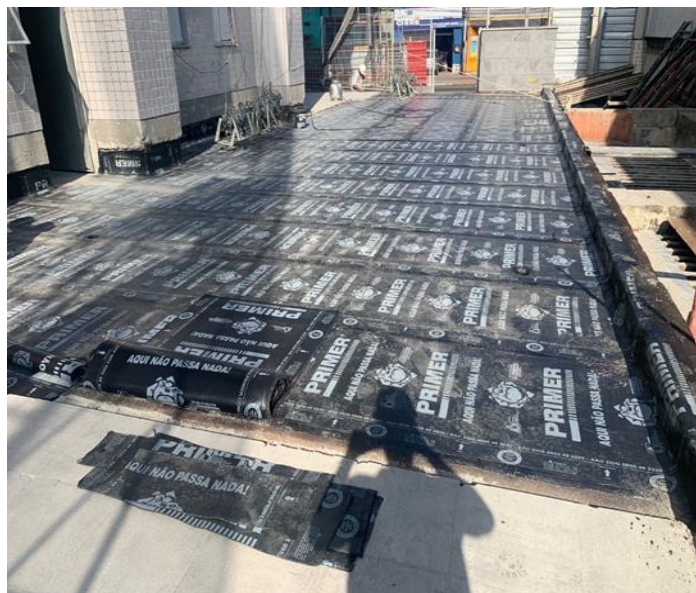
INSTALAÇÃO DA PROTEÇÃO COM MANTA NO PISO TERREO
