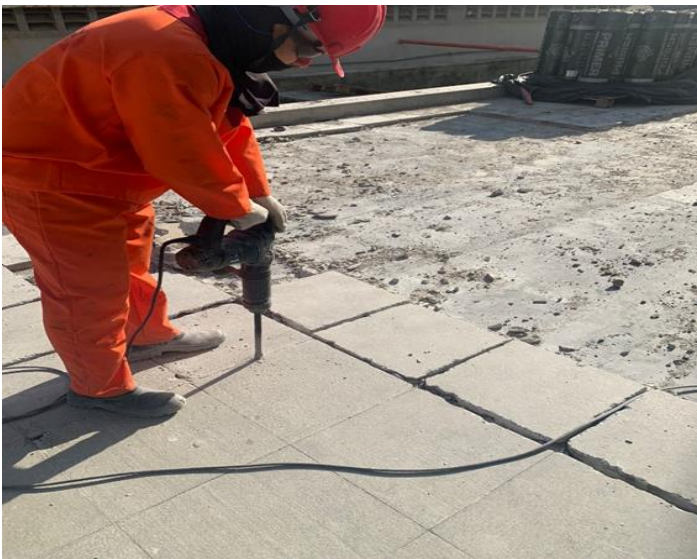
DEMOLIÇÃO DO PISO TERREO
