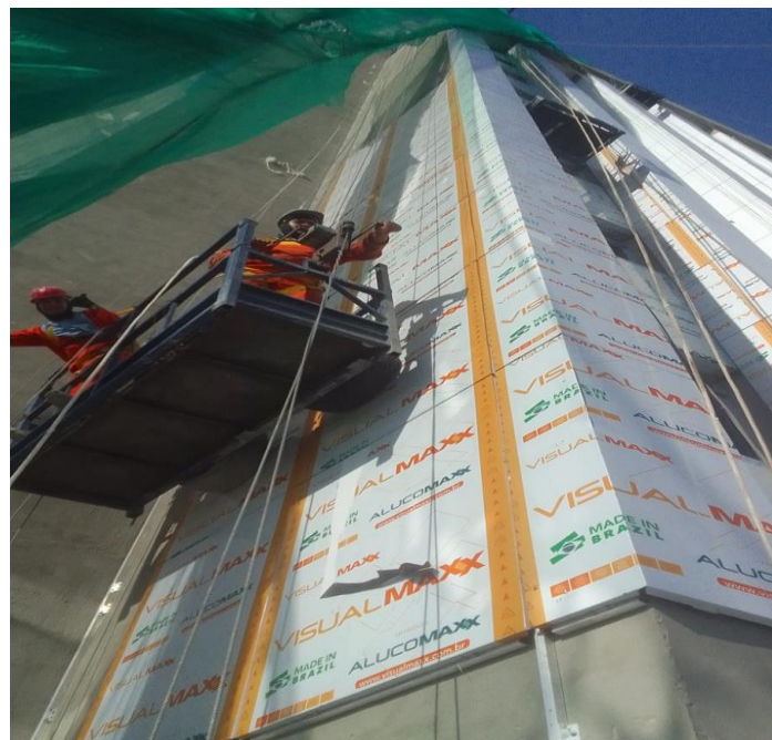
INSTALAÇÃO DA ESTRUTURA EM ACM NA FACHADA OESTE
