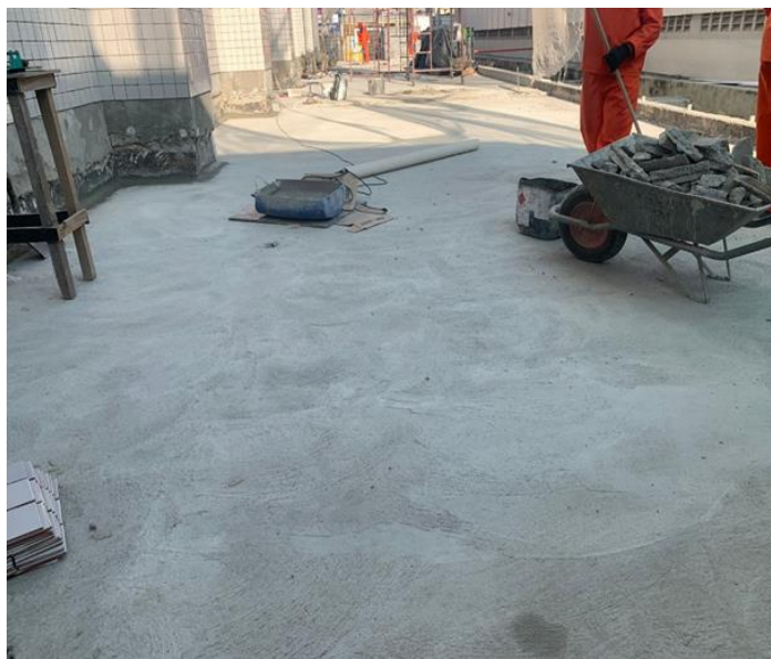
REGULARIZAÇÃO DO PISO TERREO
