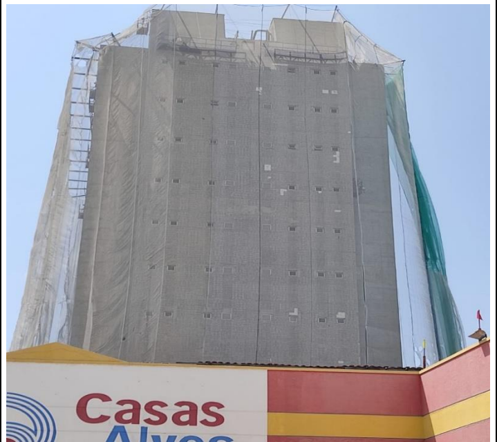
DEMOLIÇÃO E REGULARIZAÇÃO DA FACHADA OESTE
