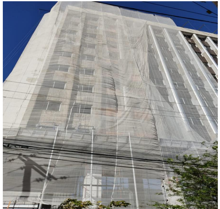
DEMOLIÇÃO E REGULARIZAÇÃO DE REVESTIMENTO DA FACHADA NORTE
