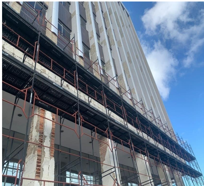
MONTAGEM DE BANDEJAS E BALANCINS NA FACHADA NORTE
