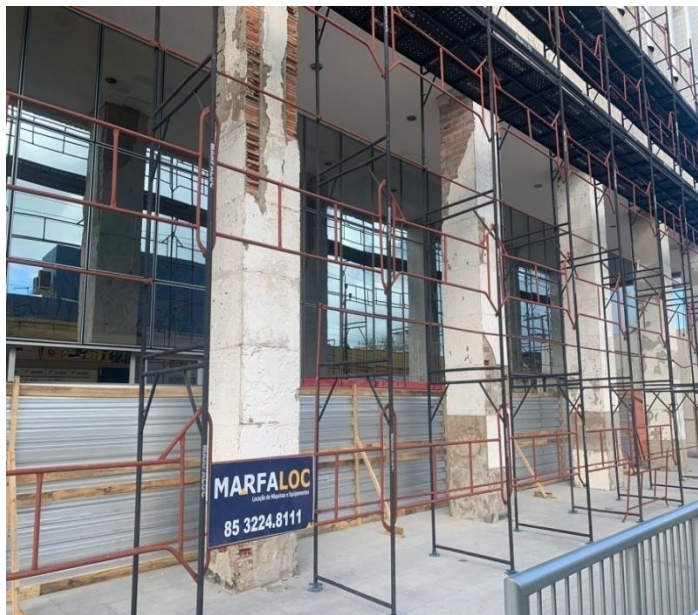
MONTAGEM DE BANDEJAS E BALANCINS NA FACHADA NORTE
