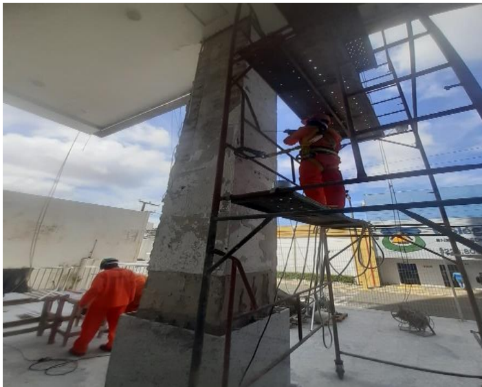
REVESTIMENTO DE GRANITO EM PILARES
