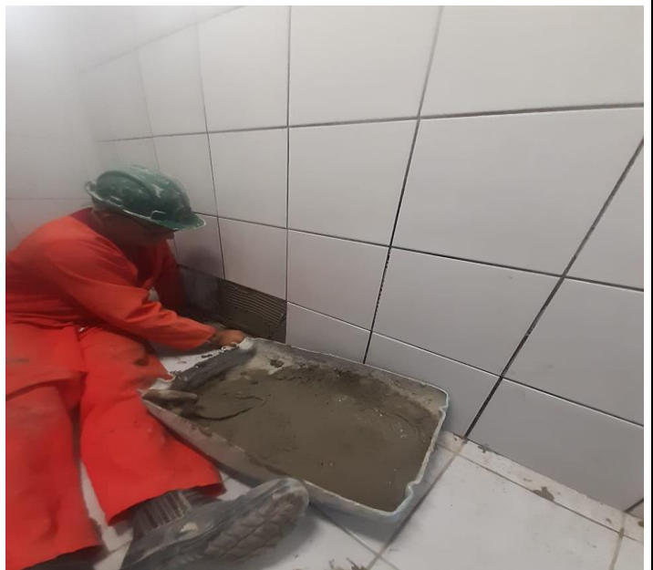
ASSENTAMENTO DE REVESTIMENTO CERÂMICO EM PAREDE
