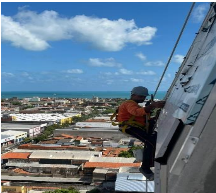
INSTALAÇÃO DE ESTRUTURA EM ACM
