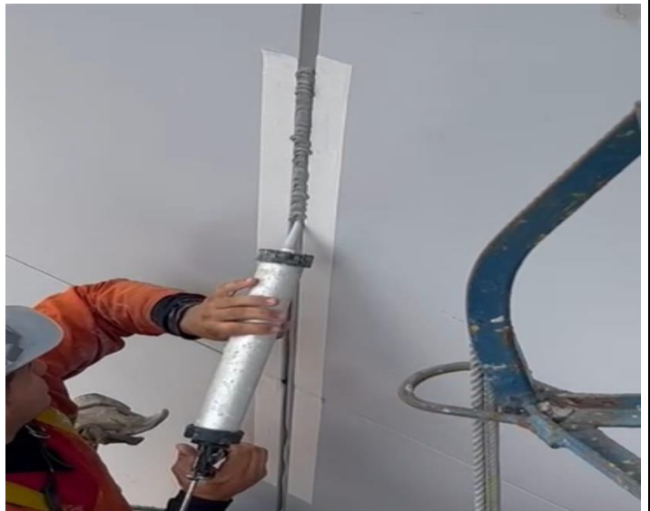
EXECUÇÃO DE JUNTAS EM REVESTIMENTO DE ACM
