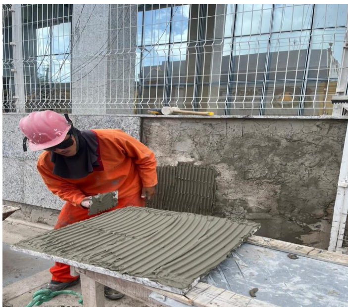
ASSENTAMENTO DE PEÇAS EM GRANITO
