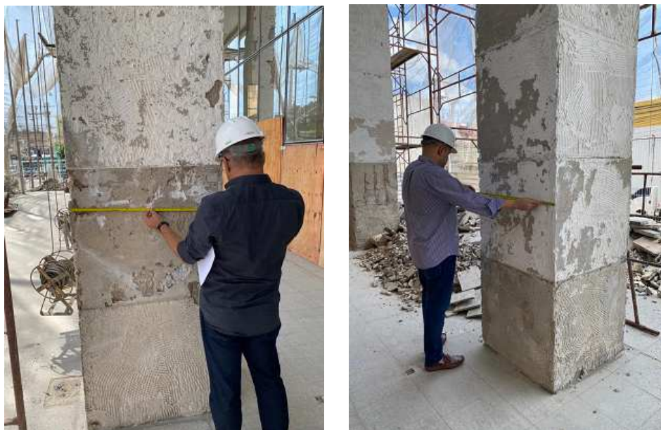
Fotos 01 e 02 – Estado atual dos Pilares da Fachada Norte após a retirada do antigo revestimento de granito.
