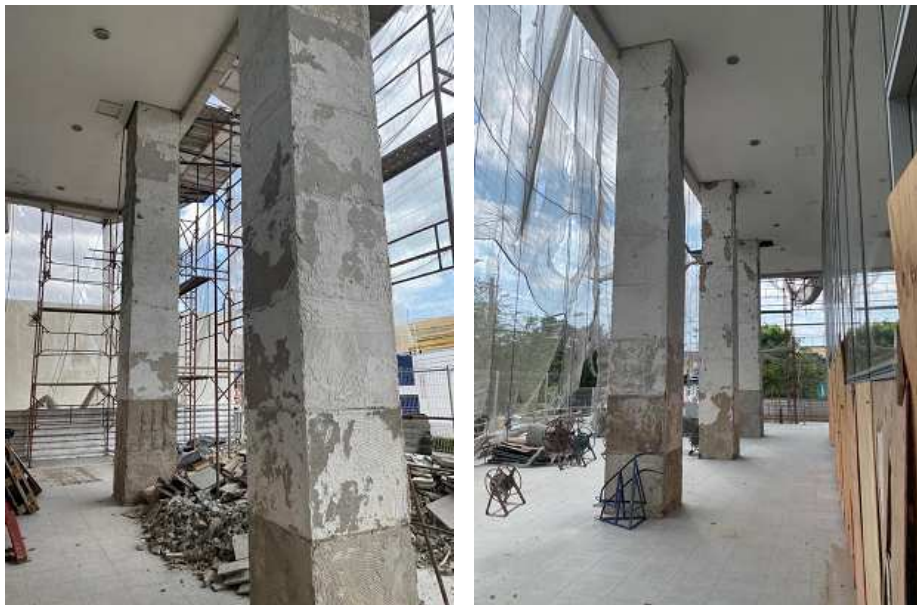
Fotos 01 e 02 – Estado atual dos Pilares da Fachada Norte após a retirada do antigo revestimento de granito.
