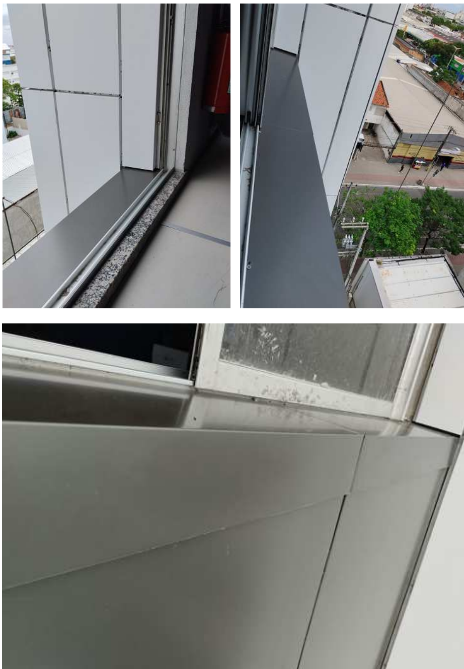
Foto 06, 07 e 08 – Protótipo de sobreposição de peitoril de granito existente com revestimento de Placa em Alumínio Composto (ACM) na mesma tonalidade do painel da fachada, garantindo a estanqueidade e a durabilidade do sistema.
