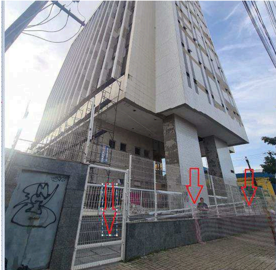
Foto 04 – Rampa de acesso de pedestres a entrada do prédio na Fachada Leste, utilizada diariamente pelos usuários, servidores e operadores do Direito da Justiça do Trabalho, impossibilitado a montagem dos andaimes fachadeiros e a interdição do local durante o prazo de execução da obra.
