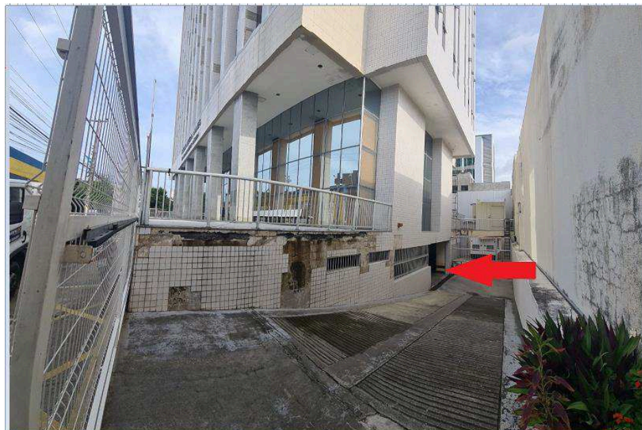
Foto 03 – Rampa de acesso de veículos ao subsolo do prédio na Fachada Oeste, utilizada diariamente pelos magistrados, impossibilitado a montagem dos andaimes fachadeiros e a interdição do local durante o prazo de execução da obra.
