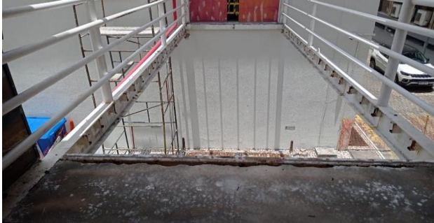
FOTO 13 - Remoção dos perfis no sentido transversal da passarela e dos tubos condenados da estrutura da cobertura.
