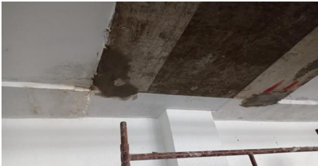
FOTO 03 - Recomposição de laje no Subsolo II.
