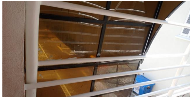
FOTO 16 - Pintura em epóxi da estrutura da cobertura.
