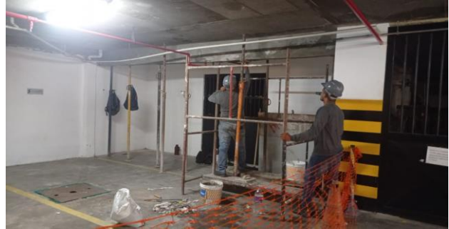
FOTO 02 - Recomposição de viga no Subsolo II.
