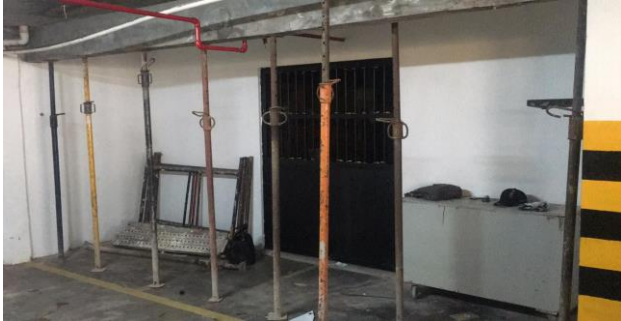
FOTO 01 - Recomposição de viga no Subsolo II.
