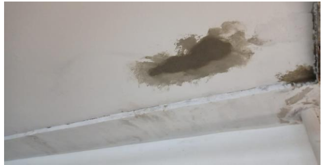
FOTO 04 - Recomposição de laje no Subsolo I.
