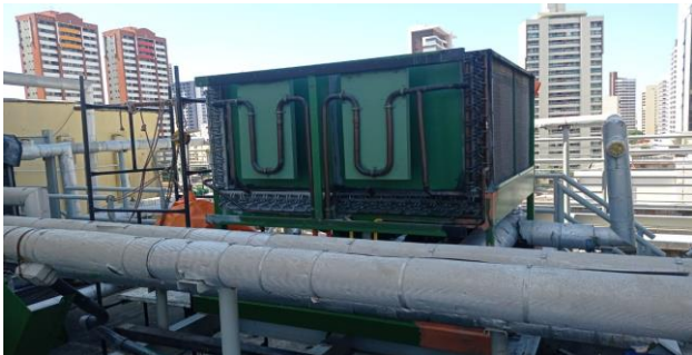
FOTO 19 - Recuperação estrutural dos chillers e bases das bombas.
