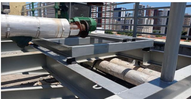
FOTO 21- Recuperação estrutural dos chillers e bases das bombas.
