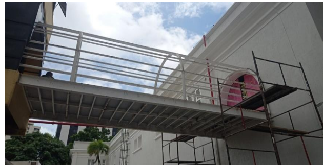
FOTO 10 - Remoção da cobertura de policarbonato.
