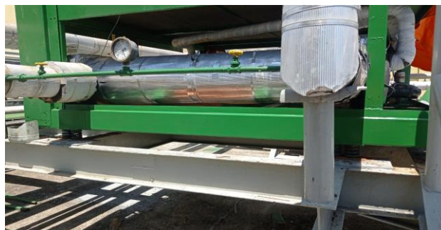
FOTO 22 - Recuperação estrutural dos chillers e bases das bombas.
