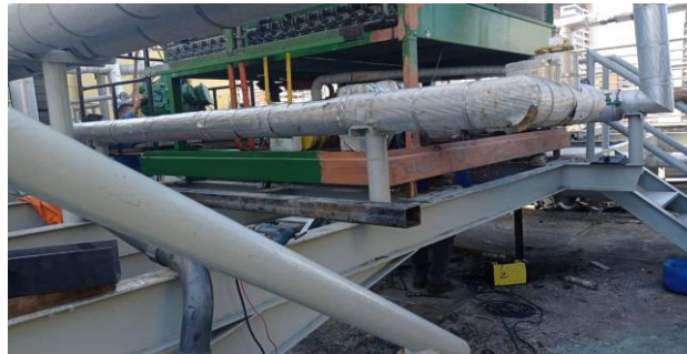
FOTO 20 - Recuperação estrutural dos chillers e bases das bombas.
