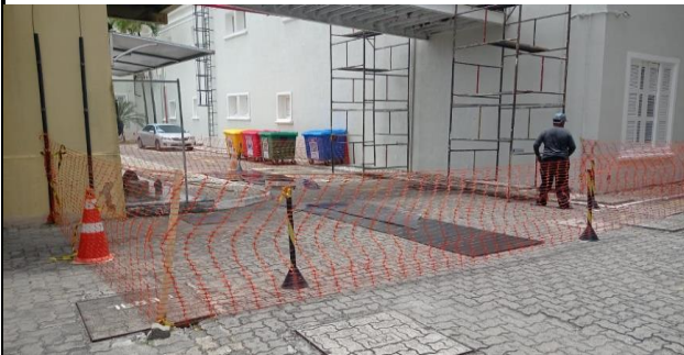
FOTO 09 - Interdição e sinalização da parte de baixo da Passarela Casa Sede / Anexo II.
