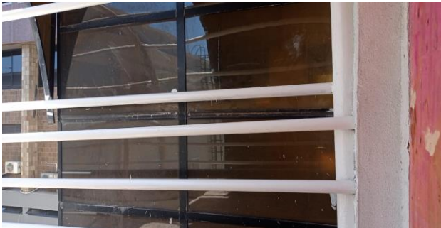
FOTO 15 - Pintura em epóxi da estrutura da cobertura.
