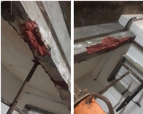
FOTO 05 - Recomposição de viga no Subsolo II.
