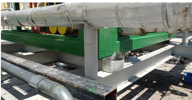
FOTO 23- Recuperação estrutural dos chillers e bases das bombas.
