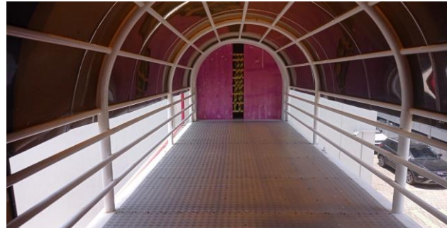
FOTO 08 - Interdição da Passarela Casa Sede / Anexo II.
