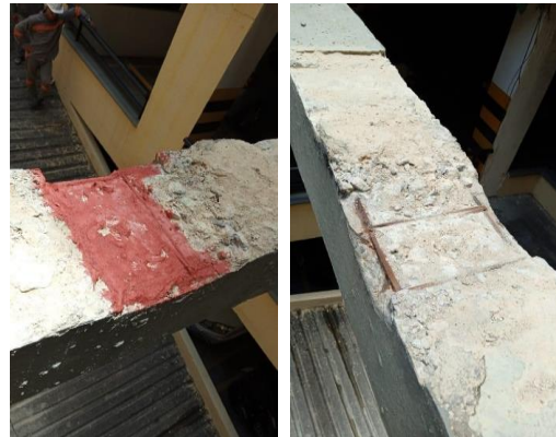
FOTO 06 - Recomposição de viga na rampa de acesso ao Subsolo II.
