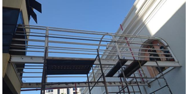
FOTO 14 - Instalação do tubos novos da estrutura da cobertura.
