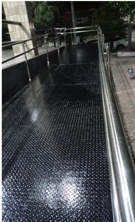
FOTO 25 - Conclusão da reforma da rampa de acesso cadeirante.
