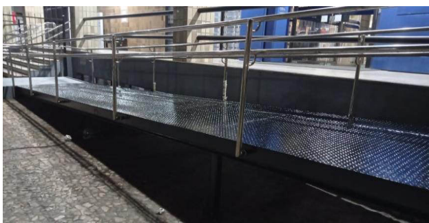
FOTO 23 - Pintura do piso em chapa xadrez com tinta epóxi.
