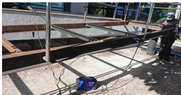
FOTO 10 - Corte e soldagem dos perfis tipo "U" novos.
