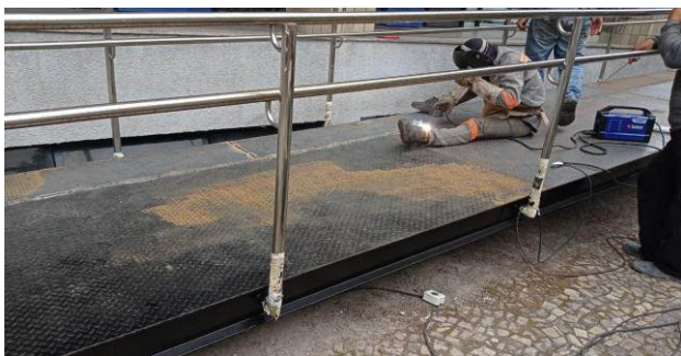
FOTO 17 - Soldagem das junções chapas.
