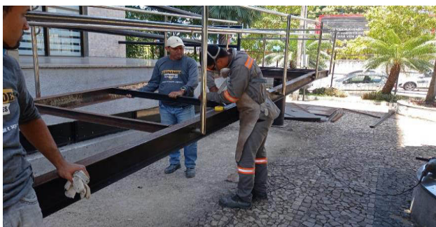
FOTO 09 - Corte e soldagem dos perfis tipo "U" novos.
