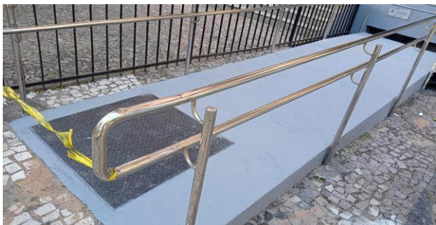
FOTO 19 - Pintura do piso de concreto no início da rampa.
