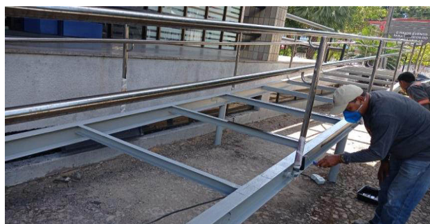
FOTO 12 - Aplicação de primer.
