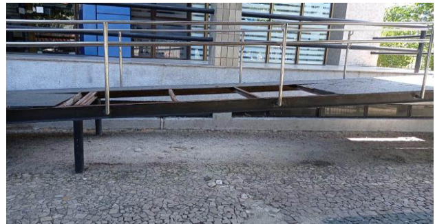
FOTO 04 - Remoção das chapas cortadas.
