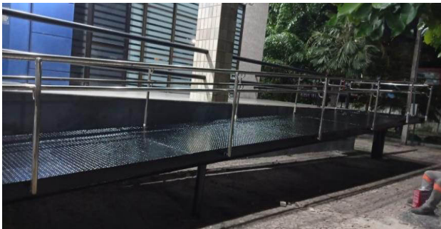
FOTO 26 - Pintura do piso em chapa xadrez com tinta epóxi.
