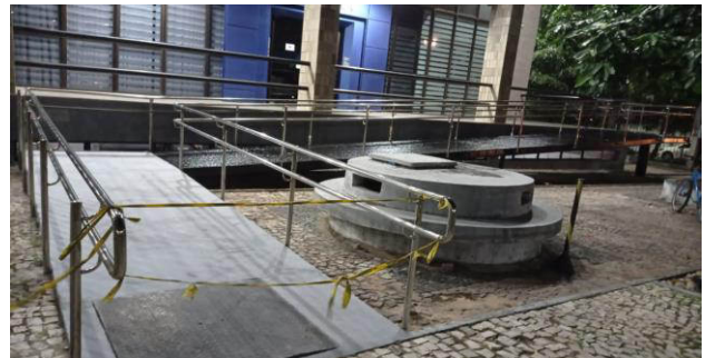
FOTO 27 - Pintura do piso em chapa xadrez com tinta epóxi.
