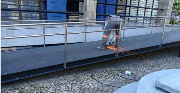
FOTO 01 - Corte nos pontos de solda das chapas a serem removidas.
