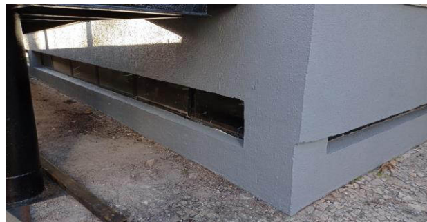
FOTO 20 - Pintura parede lateral da rampa de acesso.
