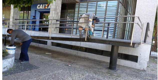
FOTO 02 - Corte nos pontos de solda das chapas a serem removidas.
