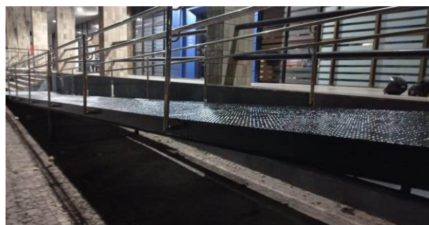
FOTO 24 - Pintura do piso em chapa xadrez com tinta epóxi.
