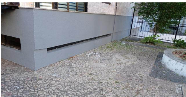
FOTO 21- Pintura parede lateral da rampa de acesso.
