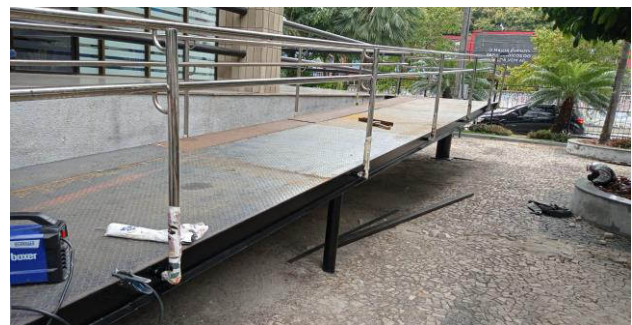
FOTO 18 - Soldagem das junções chapas.
