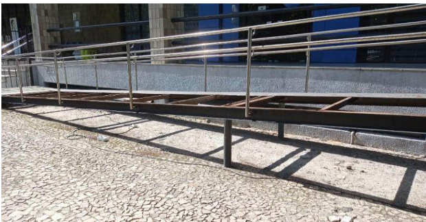
FOTO 05 - Remoção das chapas cortadas.
