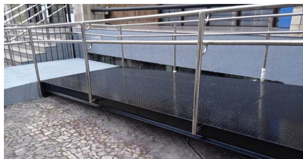
FOTO 22 - Pintura do piso em chapa xadrez com tinta epóxi.
