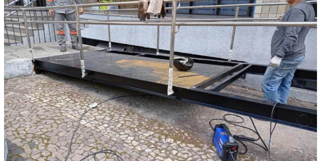
FOTO 14 - Instalação e ponteamto das chapas.
