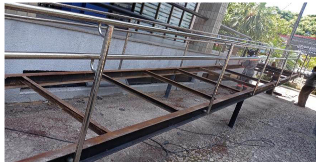
FOTO 06 - Remoção das chapas cortadas.
