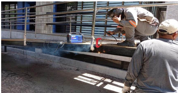
FOTO 15 - Soldagem das chapas e cortes laterias.
