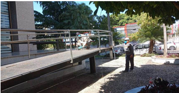
FOTO 03 - Corte nos pontos de solda das chapas a serem removidas.
