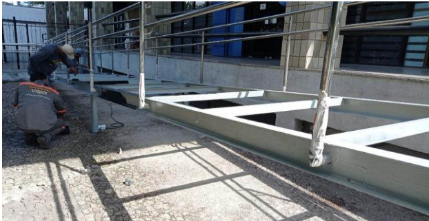
FOTO 13 - Aplicação de tinta epóxi.
