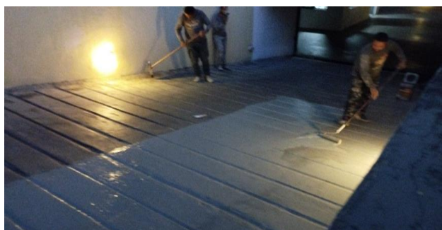
FOTO 21 - Recuperação da calha com instalação de manta e pintura.
