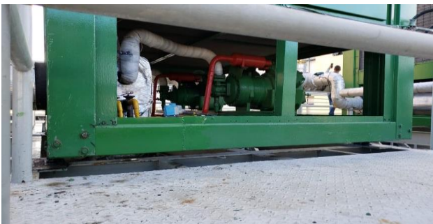
FOTO 15 - Recuperação de estrutura metálica dos chillers.
