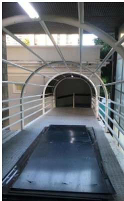
FOTO 07 - Remoção da cobertura da passarela que liga Casa sede / Anexo I.
