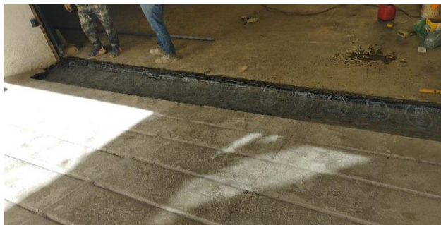
FOTO 19 - Recuperação da calha com instalação de manta.
