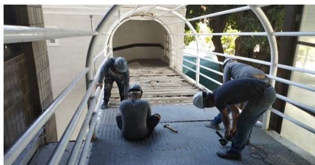
FOTO 04 - Remoção do piso em chapa xadrez da passarela que liga Casa sede / Anexo I.
