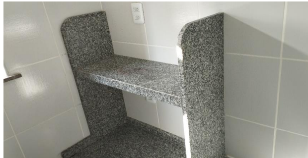
FOTO 14 - Instalação de granito na copa do gabinete.
