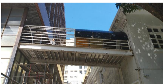
FOTO 05 - Remoção da cobertura da passarela que liga Casa sede / Anexo I.
