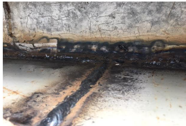
FOTO 10 - Soldagem da nova estrutura da passarela que liga Casa sede / Anexo I.
