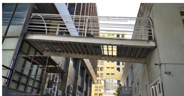
FOTO 06 - Remoção do piso em chapa xadrez da passarela que liga Casa sede / Anexo I.
