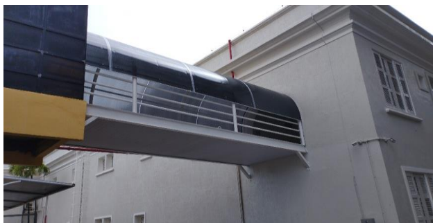
FOTO 01 - Instalação coberta de policarbonato passarela que liga Casa sede / Anexo II.
