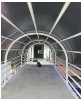
FOTO 03 - Instalação coberta de policarbonato passarela que liga Casa sede / Anexo II.
