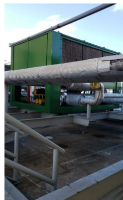
FOTO 18 - Recuperação de estrutura metálica dos chillers.
