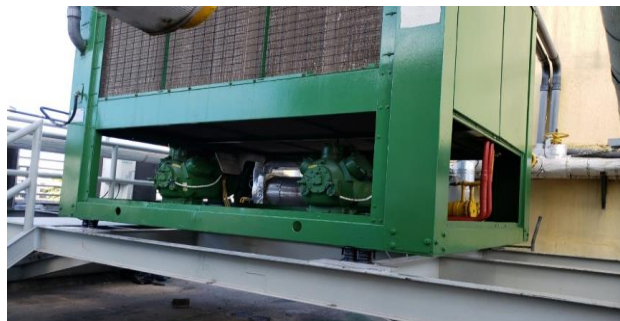
FOTO 16 - Recuperação de estrutura metálica dos chillers.
