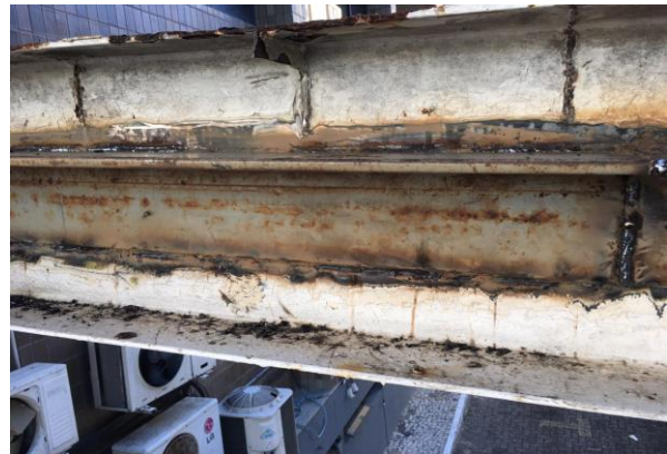
FOTO 12 - Soldagem da nova estrutura da passarela que liga Casa sede / Anexo I.
