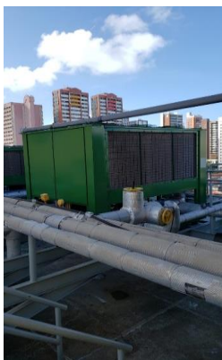
FOTO 17 - Recuperação de estrutura metálica dos chillers.
