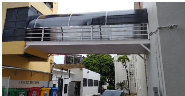
FOTO 02 - Instalação coberta de policarbonato passarela que liga Casa sede / Anexo II.
