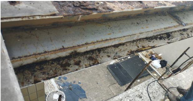
FOTO 09 - Soldagem da nova estrutura da passarela que liga Casa sede / Anexo I.
