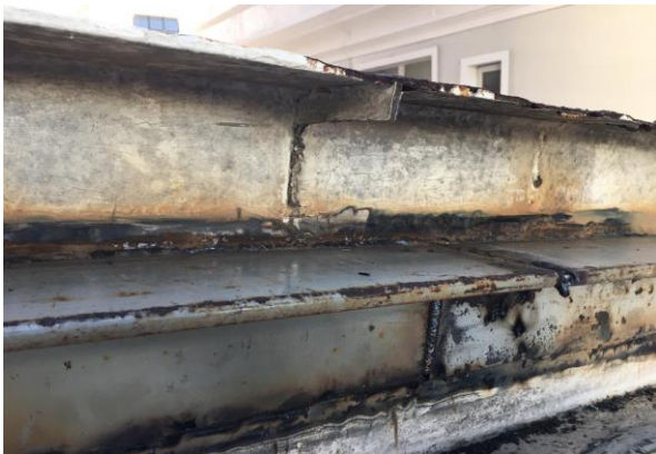
FOTO 11 - Soldagem da nova estrutura da passarela que liga Casa sede / Anexo I.
