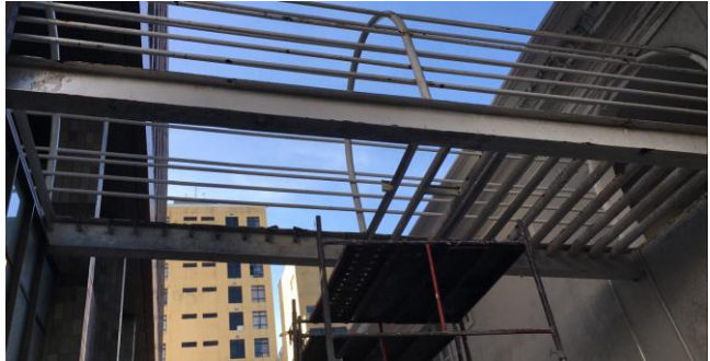
FOTO 08 - Demolição de estrutura metálica.
