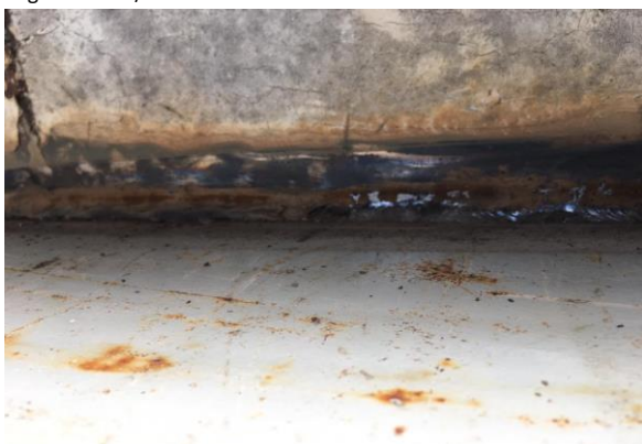
FOTO 05 - Soldagem da nova estrutura do segundo trecho da passarela que liga Anexo II / Casa Sede.
