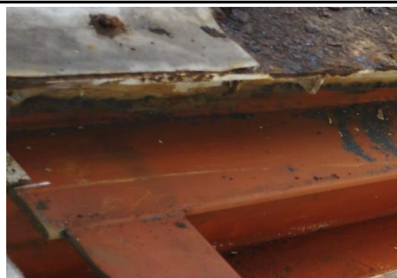
FOTO 08 - Pintura em zarcão da nova estrutura do segundo trecho da passarela que liga Anexo II / Casa Sede.
