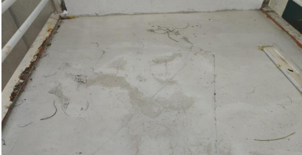
FOTO 13 - Concretagem do primeiro e do segundo trecho da passarela que liga Anexo II / Casa Sede.
