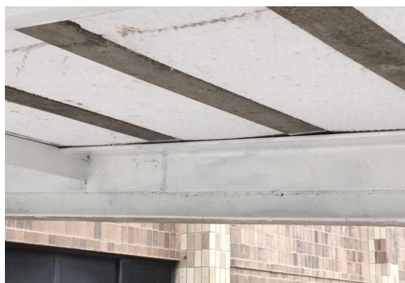
FOTO 10 - Pintura em epóxi da nova estrutura do segundo trecho da passarela que liga Anexo II / Casa Sede.
