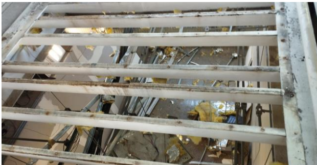
FOTO 01 - Remoção do piso em chapa xadrez de alumínio do segundo trecho da passarela que liga Anexo II / Casa Sede.
