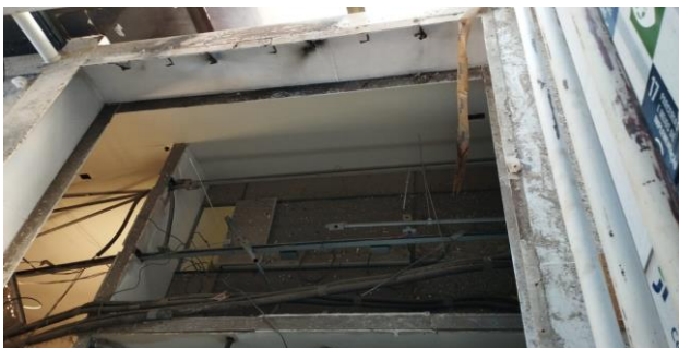
FOTO 01 - Remoção da estrutura metálica do terceiro trecho da passarela que liga Anexo I / Casa Sede.
