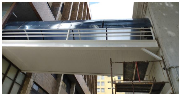
FOTO 10 - Instalação da cobertura de Policarbonato.
