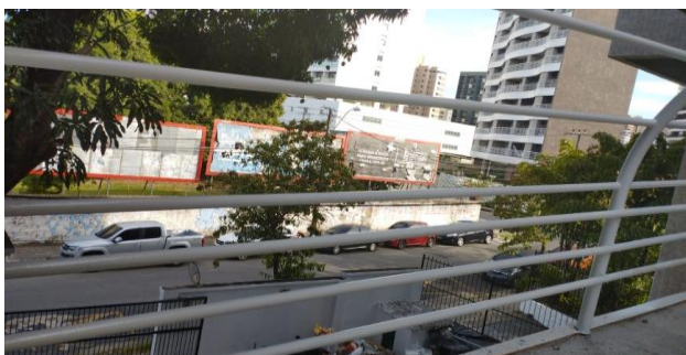
FOTO 05 - Pintura da estrutura da coberta com epóxi.
