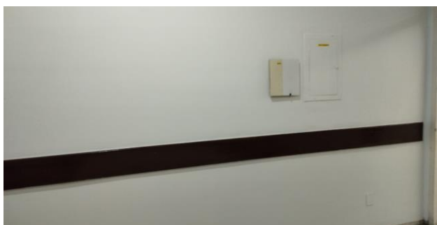
FOTO 17 - Pintura das paredes e tetos da anti sala.
