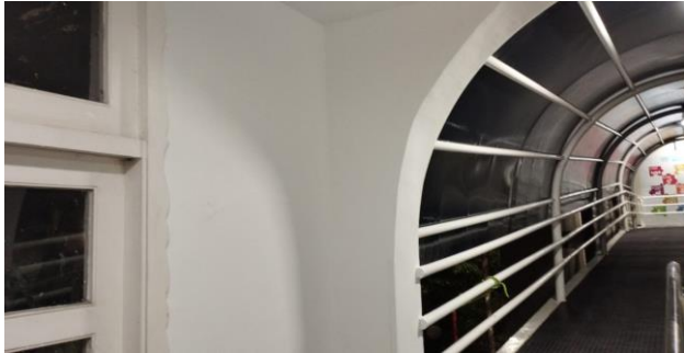
FOTO 19 - Pintura das paredes e tetos da anti sala.
