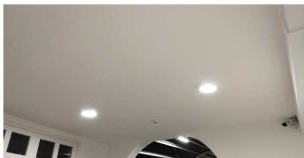
FOTO 18 - Pintura das paredes e tetos da anti sala.
