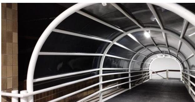
FOTO 11 - Instalação da cobertura de Policarbonato.
