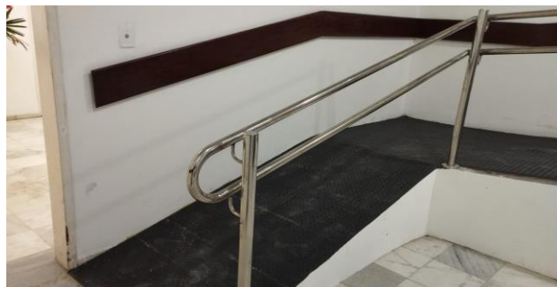
FOTO 14 - Aplicação do piso de borracha da passarela e instalação do corrimão de inox.
