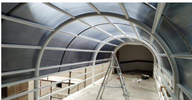
FOTO 09 - Instalação da cobertura de Policarbonato.
