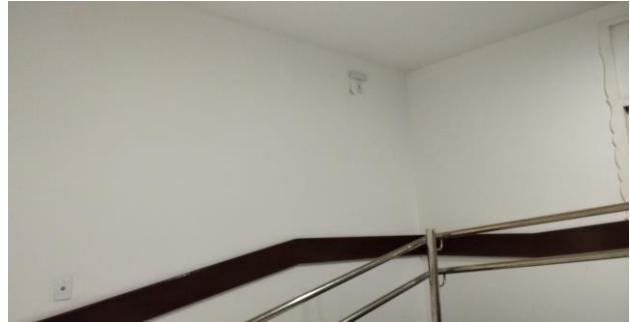
FOTO 20 - Pintura das paredes e tetos da anti sala.
