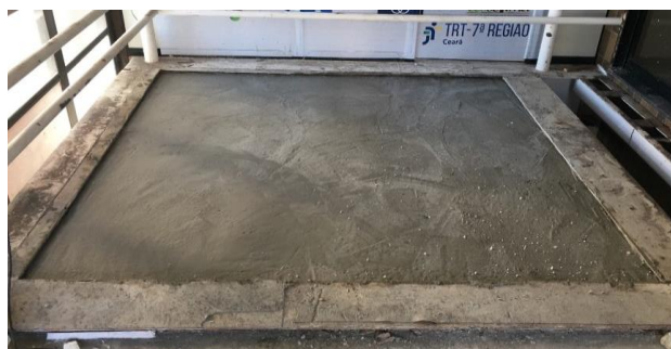
FOTO 04 - Concretagem do terceiro trecho da passarela que liga Anexo I / Casa Sede.
