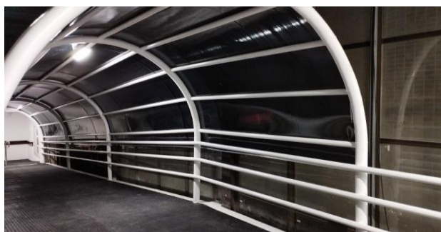
FOTO 12 - Instalação da cobertura de Policarbonato.
