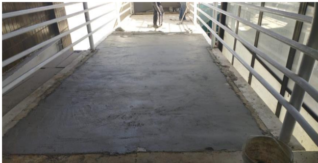
FOTO 07 - Execução de contra piso para preparo da laje para o piso de borracha.
