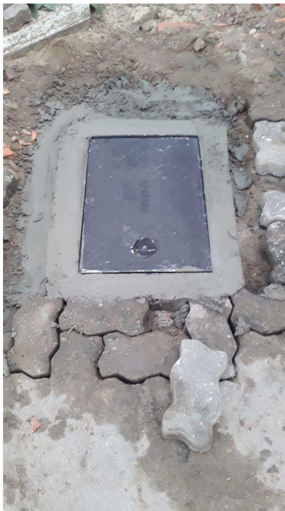
Caixa em alvenaria para hidrante de recalque – Combate a incêndio
