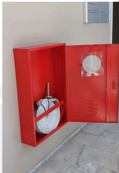
Abrigos para Rede de Hidrantes – Combate a incêndio
