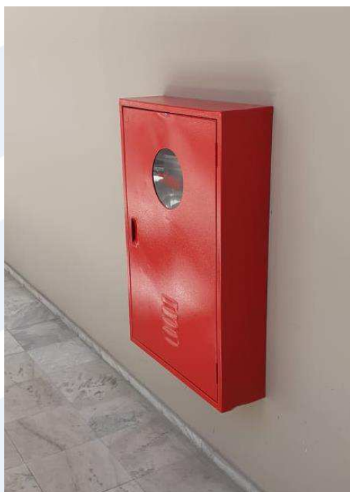
Abrigos para Rede de Hidrantes – Combate a incêndio
