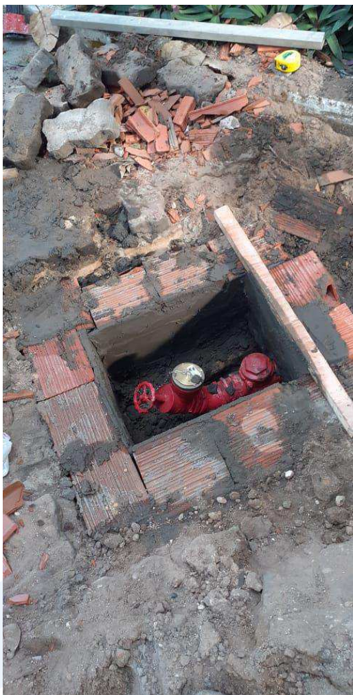
Caixa em alvenaria para hidrante de recalque – Combate a incêndio
