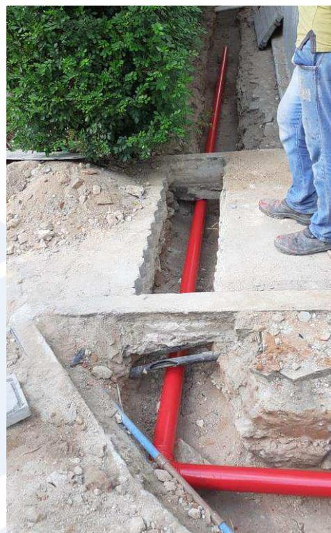
Tubulação e conexões para Rede de Hidrantes – Combate a incêndio
