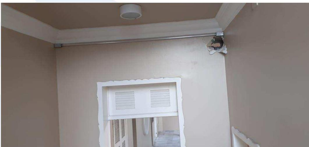
Eletrodutos e conexões de alumínio, acessórios, passagem de cabos blindados, furos em concreto –
