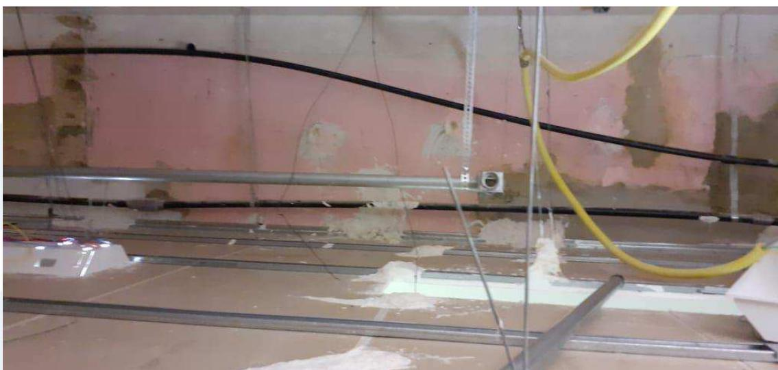
Eletródutos e conexões de alumínio, acessórios, passagem de cabos blindados – Sistema de detecção
