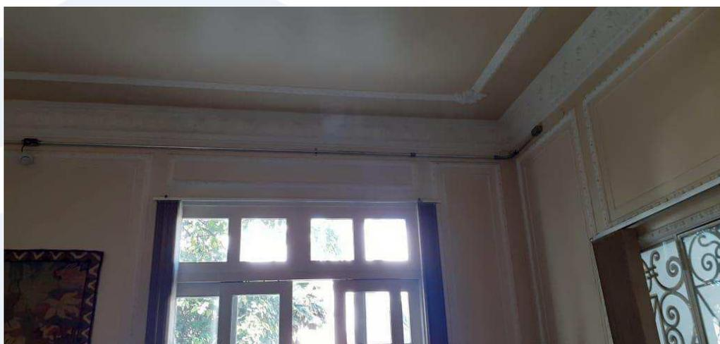
Eletrodutos e conexões de alumínio, acessórios, passagem de cabos blindados, furos em concreto – Sistema de detecção
