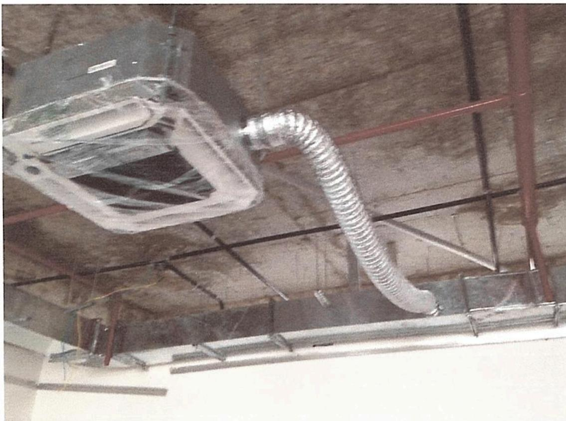
2 - TUBULAÇÕES DE DRENAGEM EXECUTADAS E COM ISOLAMENTO TÉRMICO ADEQUADO
