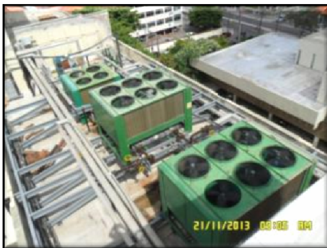
(TRT7 CE – Deslocamento Vertical de Chillers) – Montagem dos dois chillers tendo estrutura metálica como apoio.
