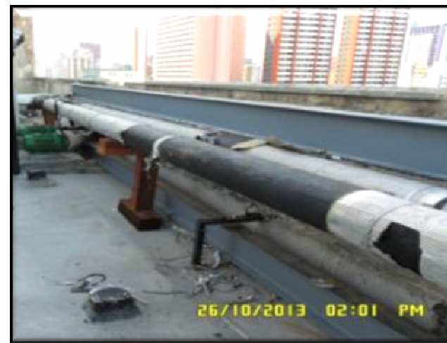
(TRT7 CE – Deslocamento Vertical de Chillers) – Readequação de tubulações das bombas.
