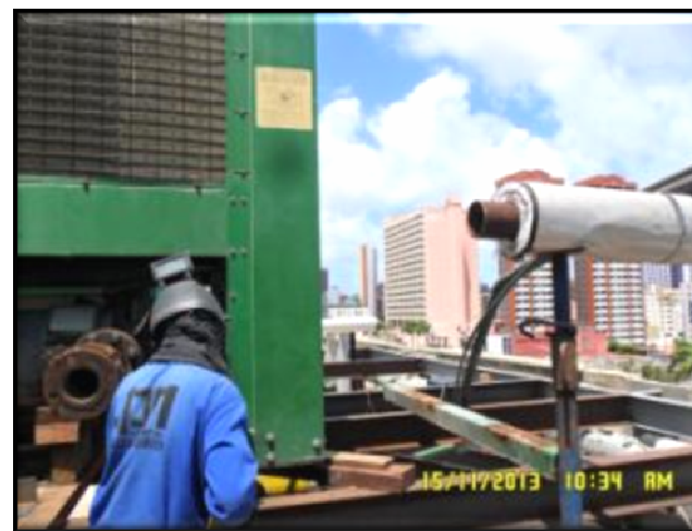
(TRT7 CE – Deslocamento Vertical de Chillers) – Desmontagem de tubulações, conexões e acessórios dos dois chillers.
