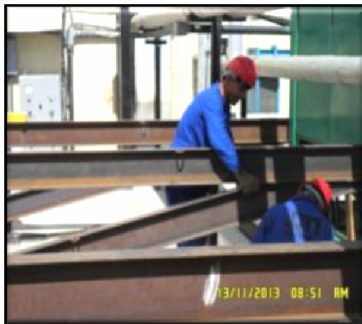
(TRT7 CE – Deslocamento Vertical de Chillers) – Execução de estruturas metálicas auxiliares para suporte dos chillers.
