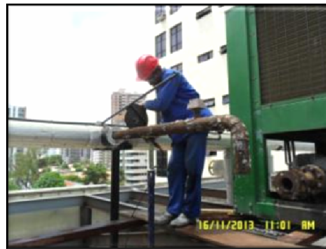
(TRT7 CE – Deslocamento Vertical de Chillers) – Desmontagem de tubulações, conexões e acessórios dos dois chillers.
