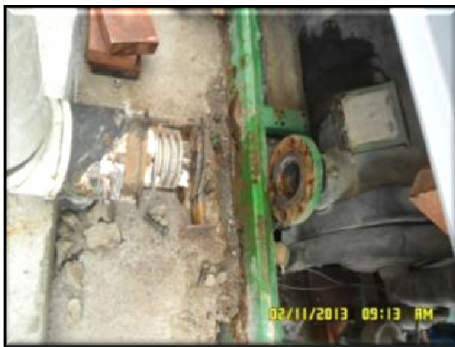
(TRT7 CE – Deslocamento Vertical de Chillers) – Desmontagem de tubulações, conexões e acessórios dos dois chillers.
