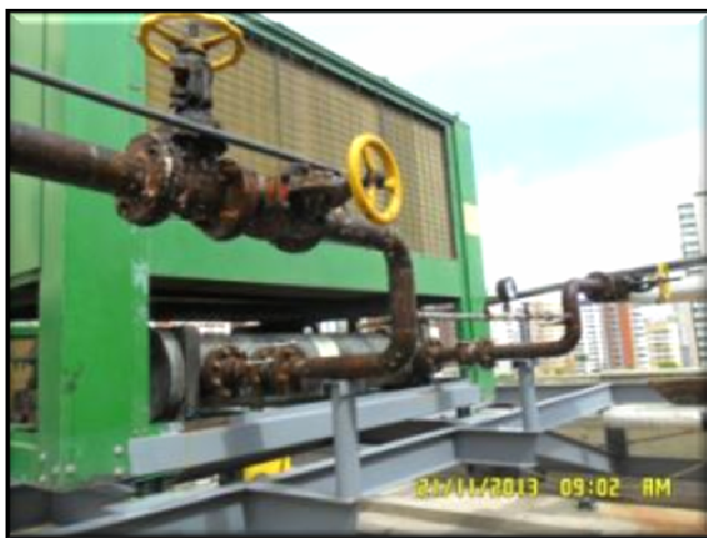
(TRT7 CE – Deslocamento Vertical de Chillers) – Montagem de tubulações, conexões e acessórios dos dois chillers.
