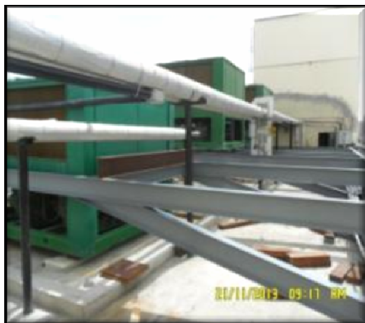
(TRT7 CE – Deslocamento Vertical de Chillers) – Execução de estruturas metálicas auxiliares para suporte dos chillers.
