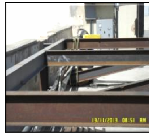
(TRT7 CE – Deslocamento Vertical de Chillers) – Execução de estruturas metálicas auxiliares para suporte dos chillers.
