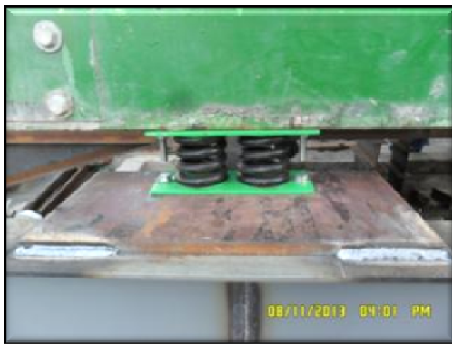
(TRT7 CE – Deslocamento Vertical de Chillers) – Instalação de vibra stop nas bases dos dois chillers.
