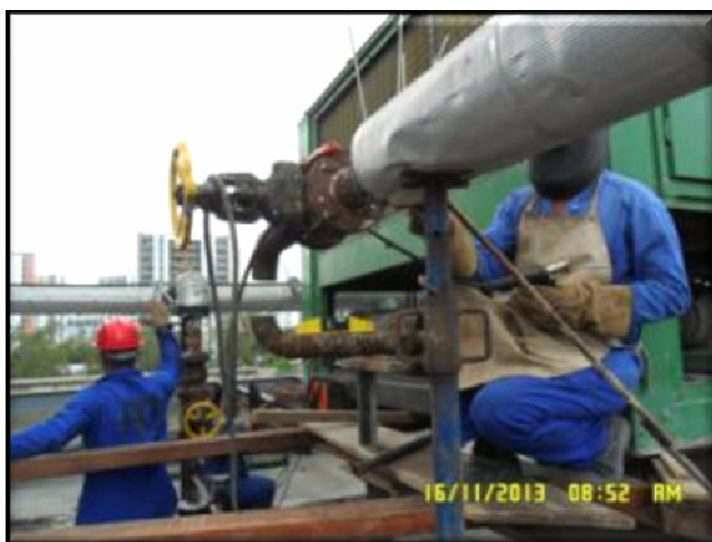
(TRT7 CE – Deslocamento Vertical de Chillers) – Desmontagem de tubulações, conexões e acessórios dos dois chillers.
