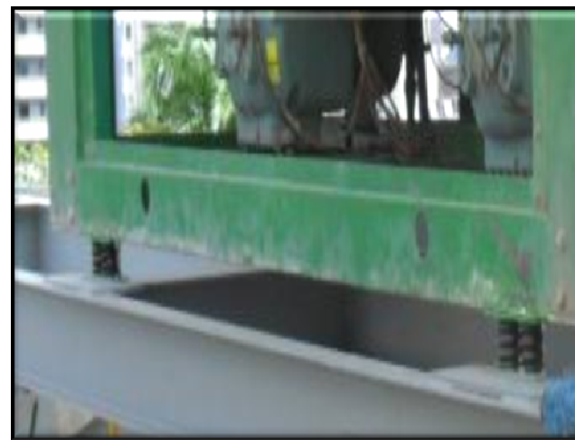
(TRT7 CE – Deslocamento Vertical de Chillers) – Instalação de vibra stop nas bases dos dois chillers.
