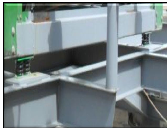
(TRT7 CE – Deslocamento Vertical de Chillers) – Instalação de vibra stop nas bases dos dois chillers.
