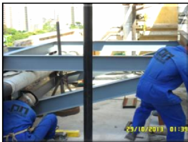
(TRT7 CE – Deslocamento Vertical de Chillers) – Readequação de tubulações das bombas.
