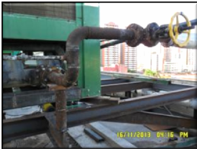
(TRT7 CE – Deslocamento Vertical de Chillers) – Montagem de tubulações, conexões e acessórios dos dois chillers.
