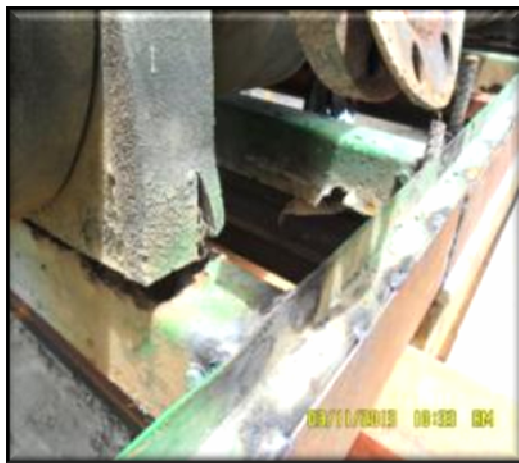
(TRT7 CE – Deslocamento Vertical de Chillers) – Recuperação das bases dos dois chillers.
