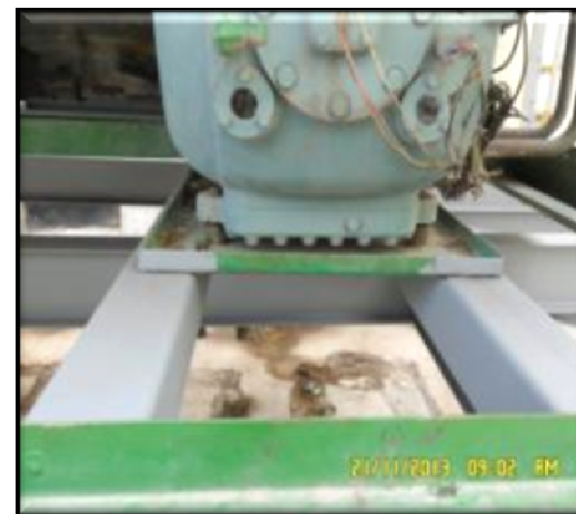
(TRT7 CE – Deslocamento Vertical de Chillers) – Recuperação das bases dos dois chillers.
