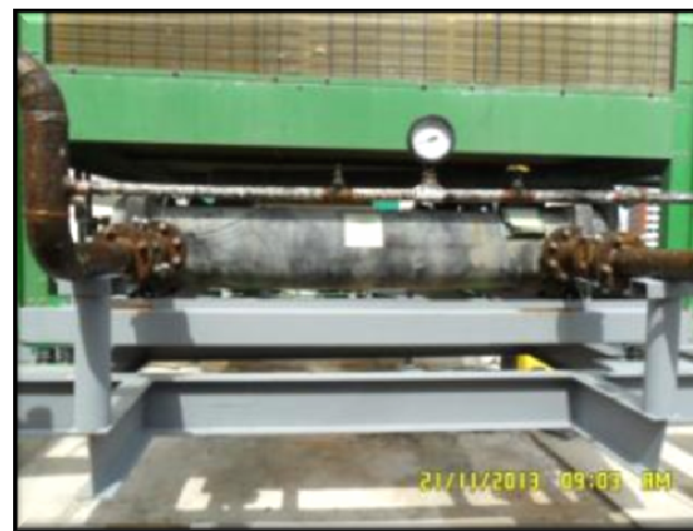
(TRT7 CE – Deslocamento Vertical de Chillers) – Montagem de tubulações, conexões e acessórios dos dois chillers.
