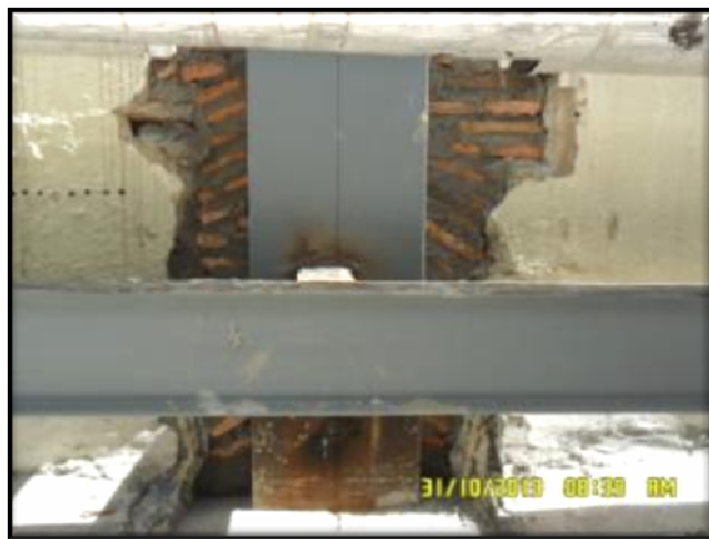
(TRT7 CE – Deslocamento Vertical de Chillers) – Recomposição de pilares em alvenaria.
