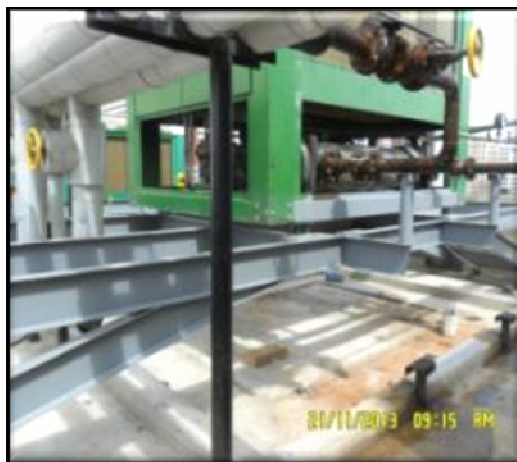
(TRT7 CE – Deslocamento Vertical de Chillers) – Execução de estruturas metálicas auxiliares para suporte dos chillers.
