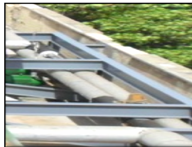
(TRT7 CE – Deslocamento Vertical de Chillers) – Readequação de tubulações das bombas.
