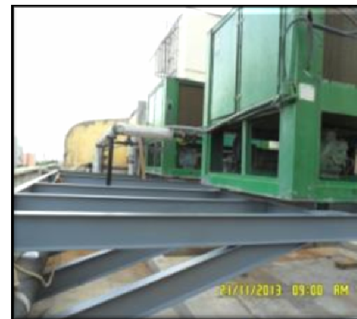
(TRT7 CE – Deslocamento Vertical de Chillers) – Execução de estruturas metálicas auxiliares para suporte dos chillers.
