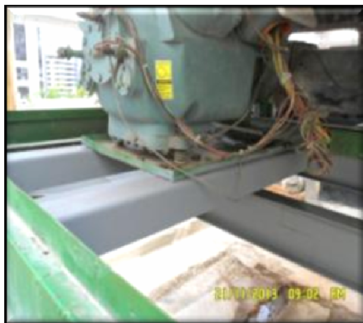
(TRT7 CE – Deslocamento Vertical de Chillers) – Recuperação das bases dos dois chillers.
