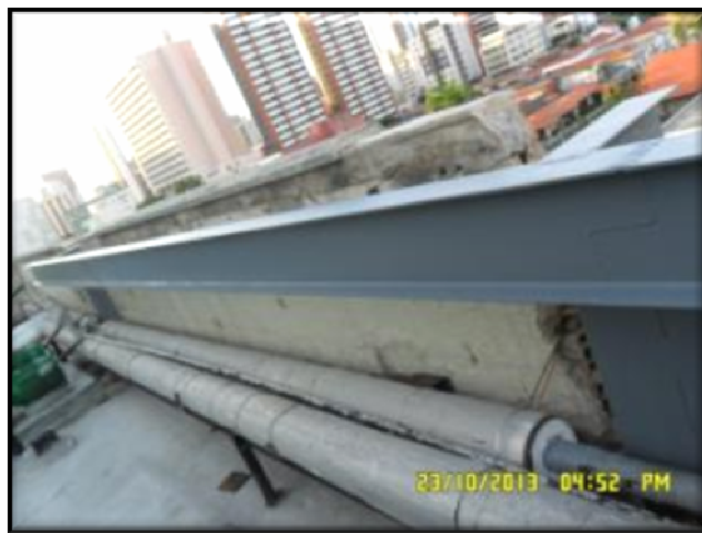
(TRT7 CE – Deslocamento Vertical de Chillers) – Readequação de tubulações das bombas.
