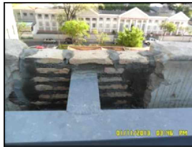
(TRT7 CE – Deslocamento Vertical de Chillers) – Recomposição de pilares em alvenaria.
