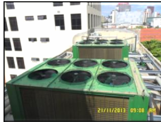
(TRT7 CE – Deslocamento Vertical de Chillers) – Montagem dos dois chillers tendo estrutura metálica como apoio.
