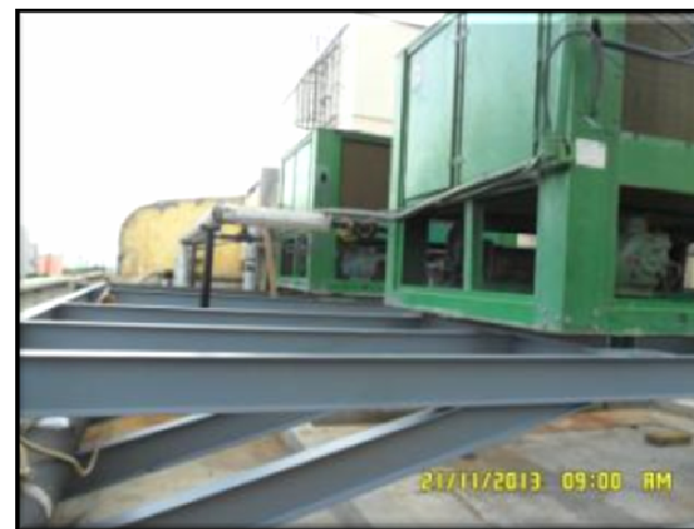
(TRT7 CE – Deslocamento Vertical de Chillers) – Montagem dos dois chillers tendo estrutura metálica como apoio.
