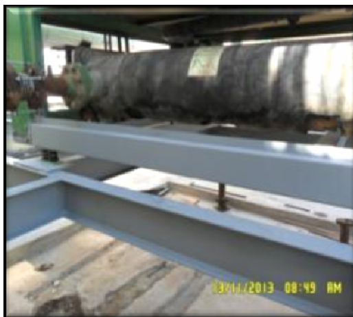
(TRT7 CE – Deslocamento Vertical de Chillers) – Recuperação das bases dos dois chillers.
