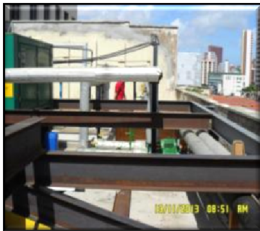
(TRT7 CE – Deslocamento Vertical de Chillers) – Execução de estruturas metálicas auxiliares para suporte dos chillers.
