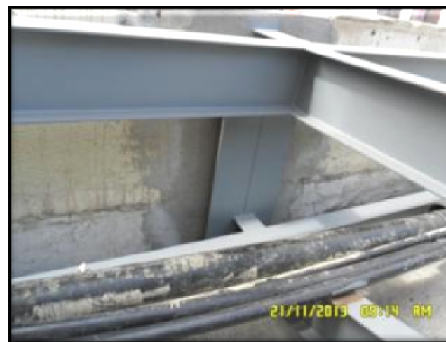
(TRT7 CE – Deslocamento Vertical de Chillers) – Recomposição de pilares em alvenaria.
