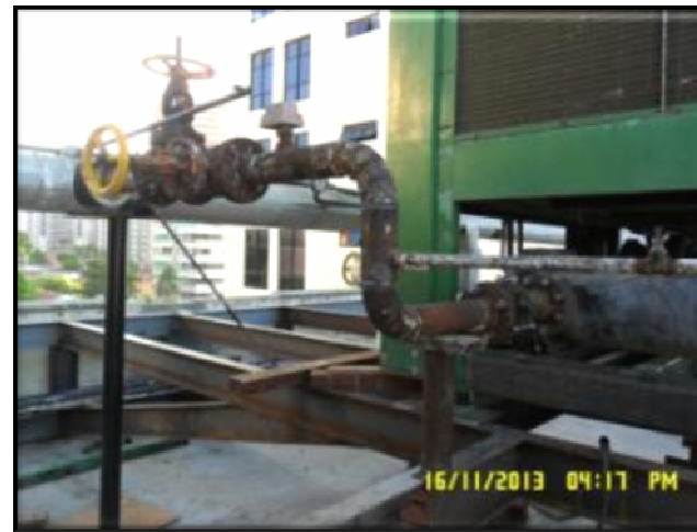
(TRT7 CE – Deslocamento Vertical de Chillers) – Montagem de tubulações, conexões e acessórios dos dois chillers.
