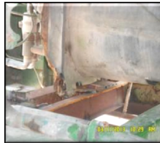
(TRT7 CE – Deslocamento Vertical de Chillers) – Recuperação das bases dos dois chillers.
