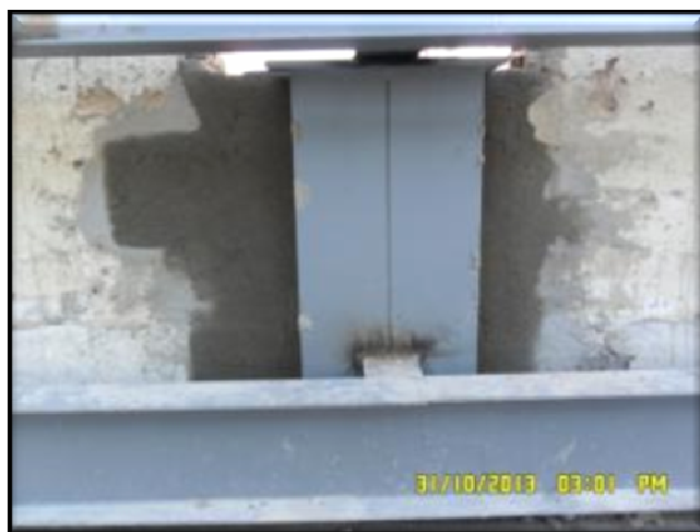
(TRT7 CE – Deslocamento Vertical de Chillers) – Recomposição de pilares em alvenaria.
