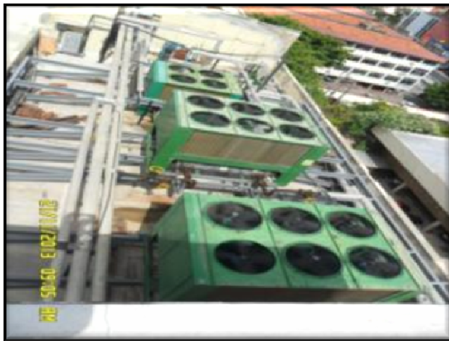
(TRT7 CE – Deslocamento Vertical de Chillers) – Montagem dos dois chillers tendo estrutura metálica como apoio.
