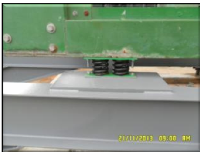
(TRT7 CE – Deslocamento Vertical de Chillers) – Instalação de vibra stop nas bases dos dois chillers.
