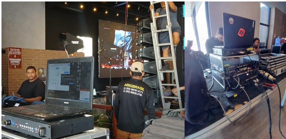
- Foto 4: MESA DE CONTROLE DOS PAINÉIS DE LED;
