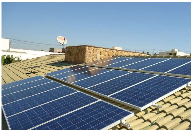
Figura -02 – Instalação em telhado
