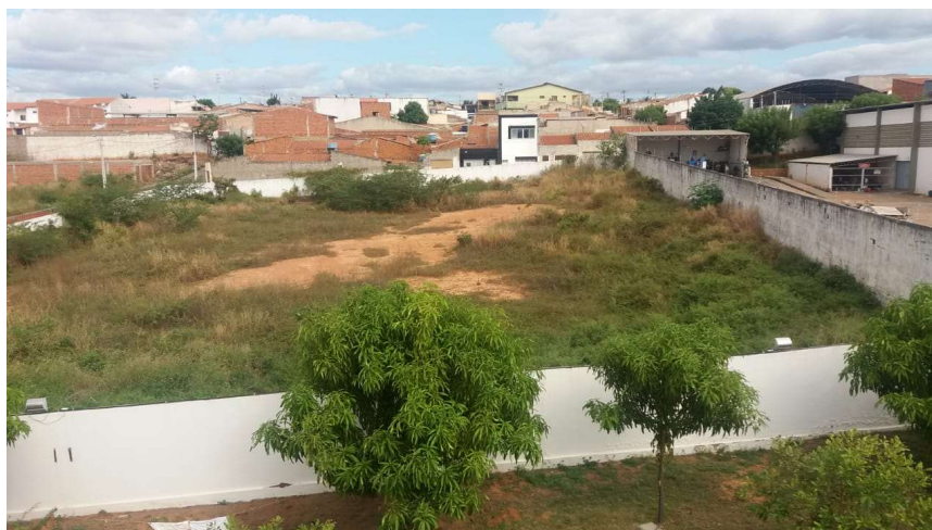
Figura 03 – Vista do terreno onde será instalada planta Fotovoltaica
