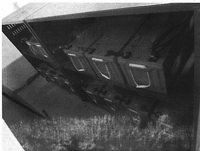
Figuras 01 e 02 – Dois gabinetes metálicos existentes para acomodação das baterias do nobreak de 160 kVA do Fórum Dom Hélder Câmara.
