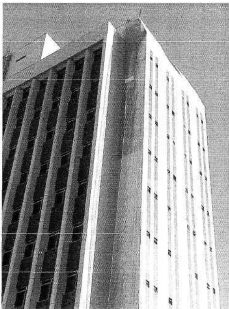
Foto 1 - Fachada Sul do Edifício D. Helder em reforma parcial.
