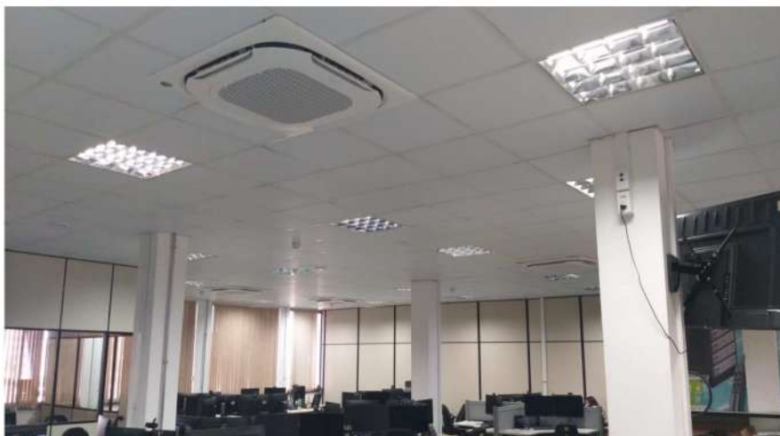
Foto 4. Implantação do novo Sistema de Ar Condicionado no Prédio Anexo II
