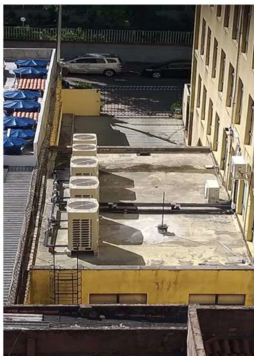
Foto 5. Implantação do novo Sistema de Ar Condicionado no Prédio Anexo II
