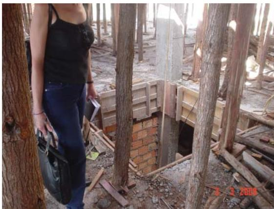
Figura 17 – Abertura de piso sem proteção
