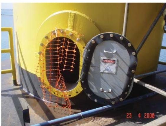
Figura 63 – Espaço confinado sem isolamento e precariamente sinalizado
