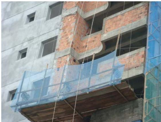
Figura 6 – Andaime suspenso mecânico montado em obra
