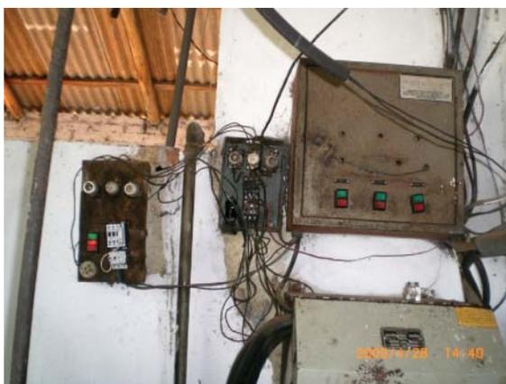
Figura 65 – Instalações elétricas improvisadas
