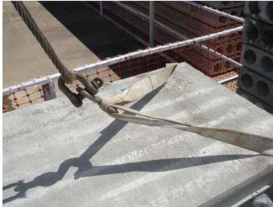
Figura 35 – Cinta de carga utilizada na movimentação e descarga de lajes pré-moldadas. Este equipamento é inadequado para a movimentação das lajes em questão
