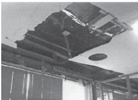
Figura 9 – Teto de gesso aberto. Partes do material já haviam caído sobre mesas e piso do local.
