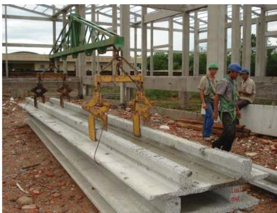
Figura 33 – Equipamento (garra) utilizado na montagem, movimentação e descarga de lajes pré-moldadas
