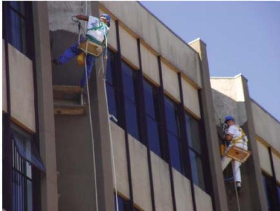
Figura 11 – Trabalhadores utilizando cadeira suspensa improvisada
