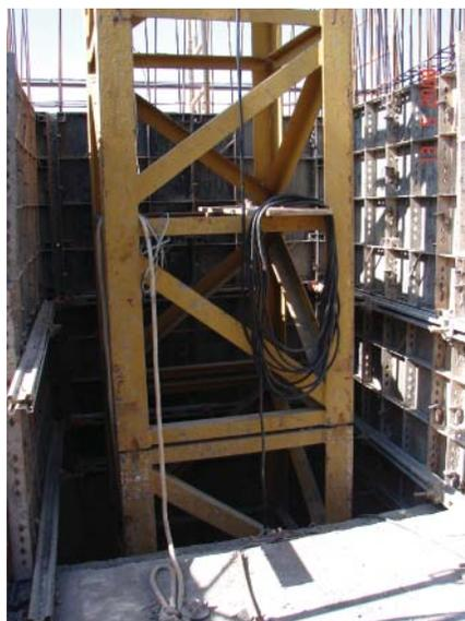
Figura 53 – Detalhe do engastamento da torre
