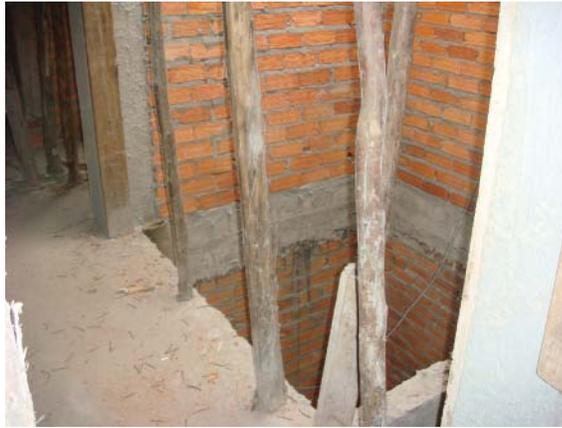
Figura 14 – Desproteção do acesso à caixa de elevador
