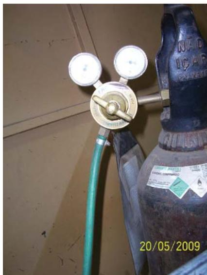
Figura 69 – Válvula de cilindro de oxigênio
