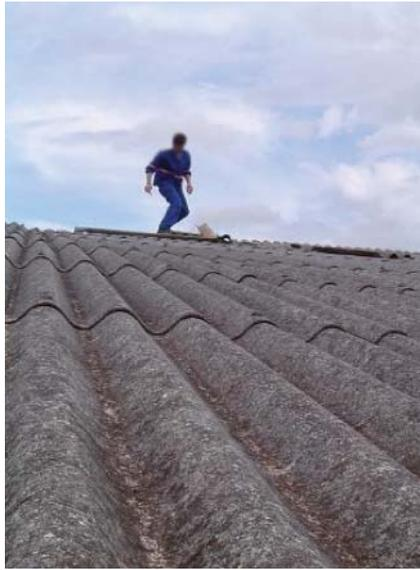
Figura 50 – Acesso e permanência precários nos serviços em telhado, com risco de queda de trabalhador
