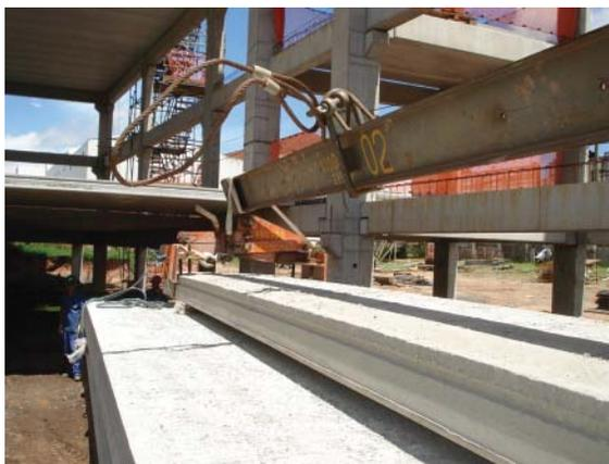
Figura 34 – Equipamento (garra), associado à cinta de carga, utilizado na montagem, movimentação e descarga de lajes pré-moldadas
