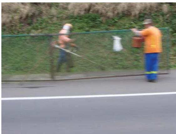
Figura 133 – Roçagem em rodovia com ausência de sinalização viária, proteção individual, rede de proteção em estado precário, fornecimento de água e armazenagem de inflamável inadequados
