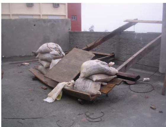
Figura 7 – Fixação e sustentação improvisada de andaime suspenso mecânico
