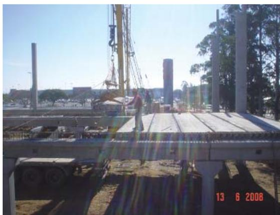
Figura 27 – A execução utilizando elementos pré-moldados de concreto está entre as tecnologias que mais expõe trabalhadores ao risco de queda
