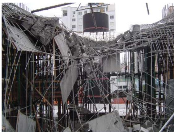
Figura 56 – Embargo por colapso estrutural do escoramento das formas
