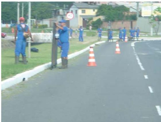
Figura 131 – Roçagem com ausência de sinalização viária adequada, proteção individual e vestimenta com alta visibilidade
