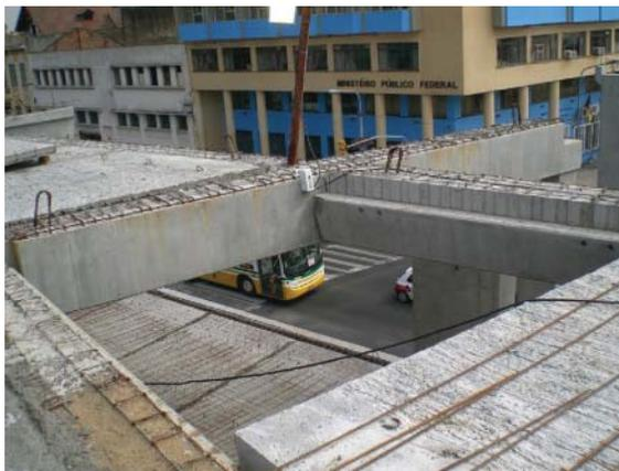
Figura 16 – Lajes com aberturas no piso sem proteção
