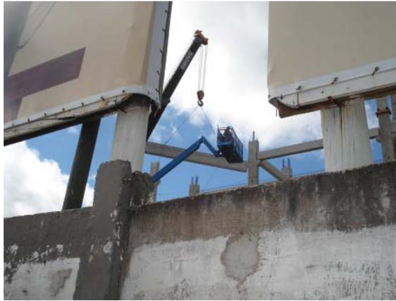
Figura 39 – Utilização simultânea de guindastes na movimentação e descarga de vigas pré-moldadas e de Plataformas de Trabalho Aéreo – PTA
