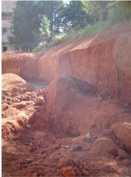
Figura 41 – Taludes sem estabilização
