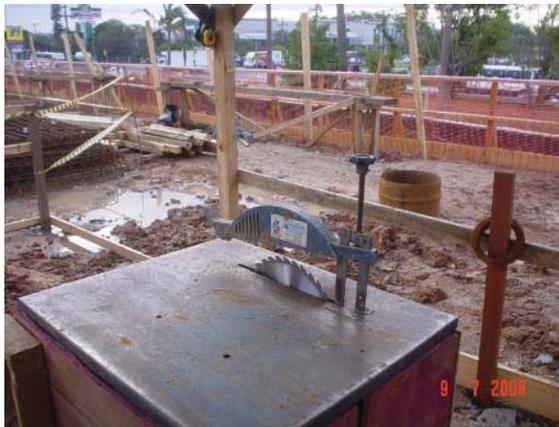
Figura 25 – Serra circular montada, com zona de operação sem proteção
