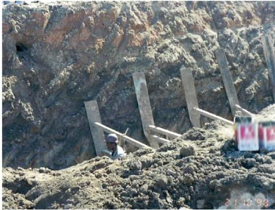
Figura 43 – Risco de colapso iminente
