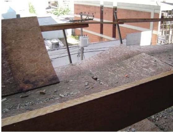
Figura 44 – Plataforma de proteção incompleta e não efetiva
