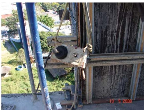
Figura 54 – Precariedade nos componentes de controle e movimentação
