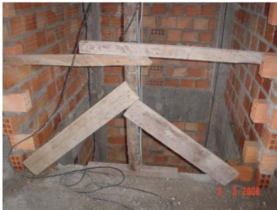
Figura 15 – Acesso à caixa do elevador com proteção inadequada
