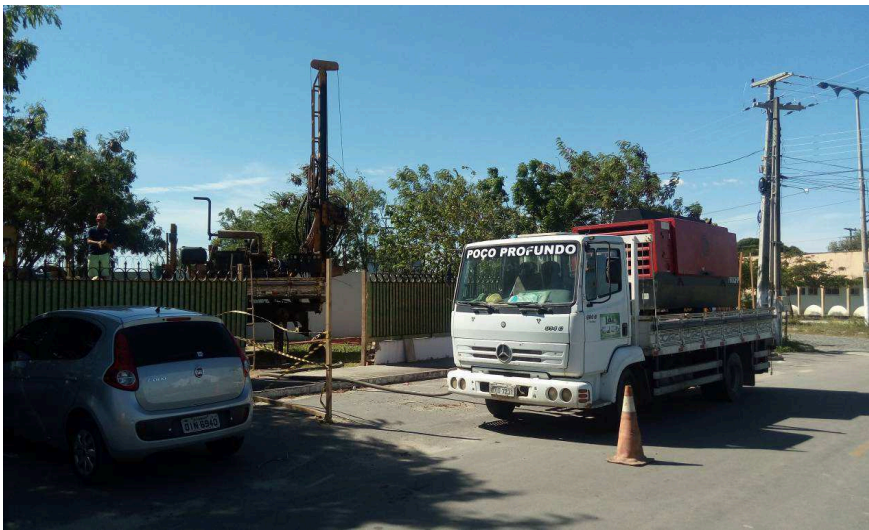
Foto nº. 1 - Vista panorâmica do canteiro de obras; operação de perfuração do poço profundo.
