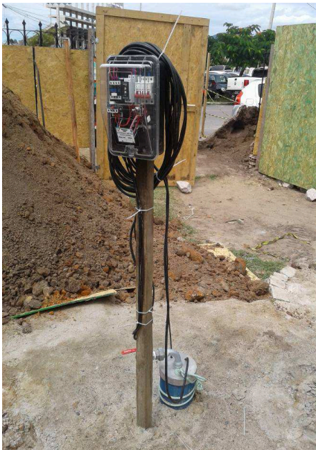
Foto nº. 2 - Poço profundo perfurado com quadro de comando da bomba submersa.
