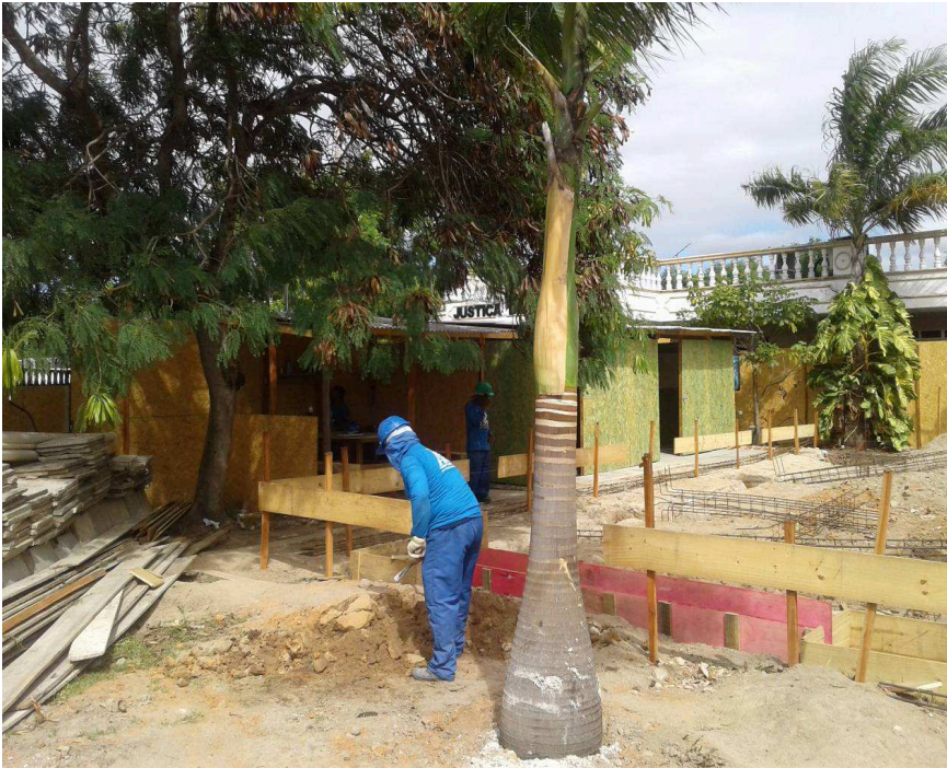
Foto nº. 4 - Vista panorâmica do canteiro de obras, instalações provisórias e locação da obra.
