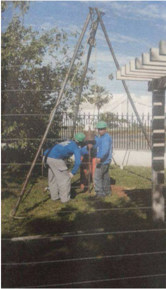
Foto nº. 3 - Execução das sondagens geotécnicas.
