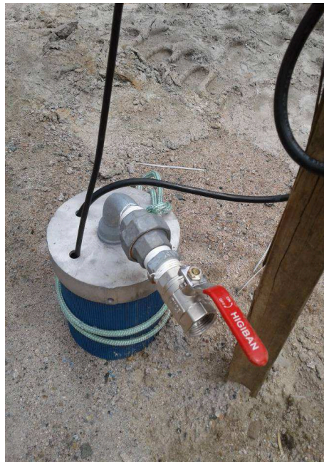
Foto nº. 2 - Poço profundo perfurado com quadro de comando da bomba submersa.
