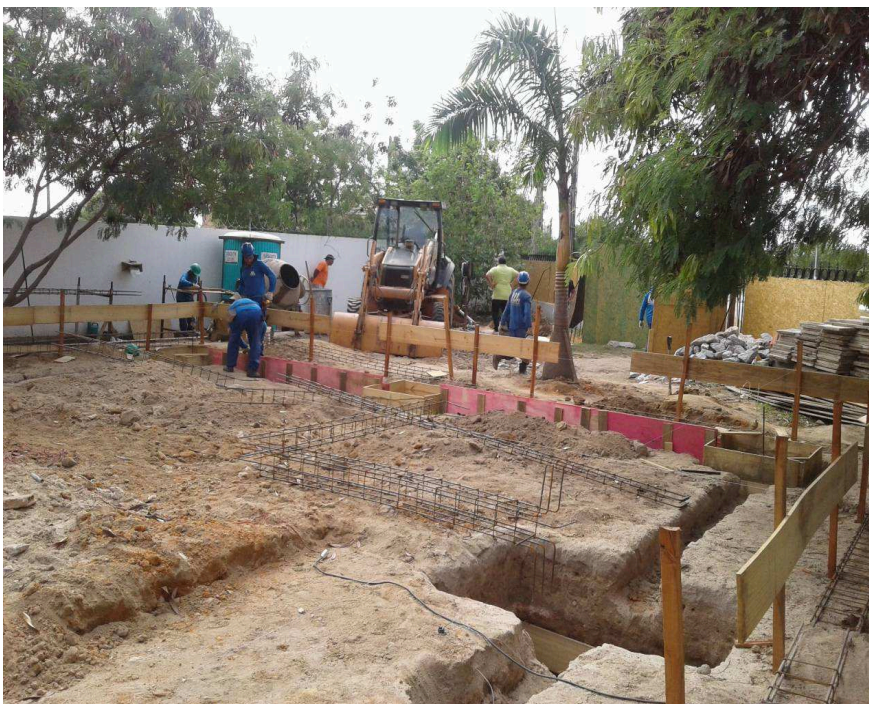
Foto nº. 5 - Outra vista panorâmica do canteiro de obras e da locação da obra.
