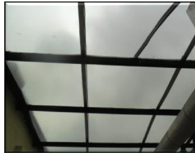
(TR7 CE – Deslocamento Vertical de Chillers) – Desmontagem de telhado em policarbonato e estruturas metálicas.
