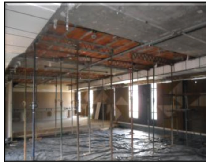
(TRT7 CE – Deslocamento Vertical de Chillers) – Escoramento de laje pré-moldada.
