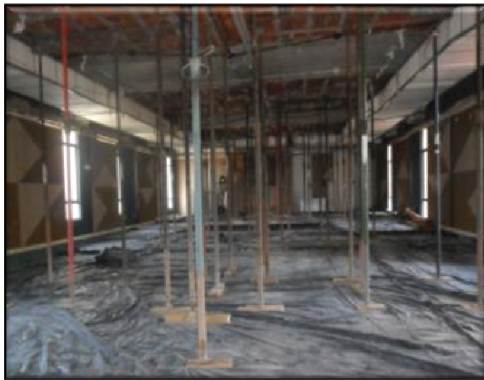
(TRT7 CE – Deslocamento Vertical de Chillers) – Escoramento de laje pré-moldada.
