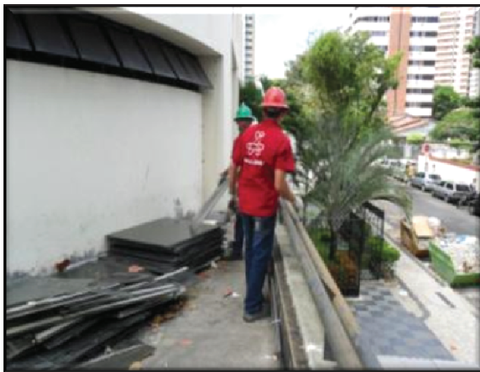
(TR7 CE – Deslocamento Vertical de Chillers) – Remanejamento de estruturas metálicas.
