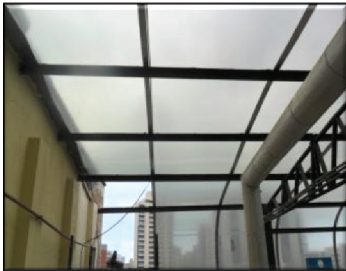
(TR7 CE – Deslocamento Vertical de Chillers) – Desmontagem de telhado em policarbonato e estruturas metálicas.
