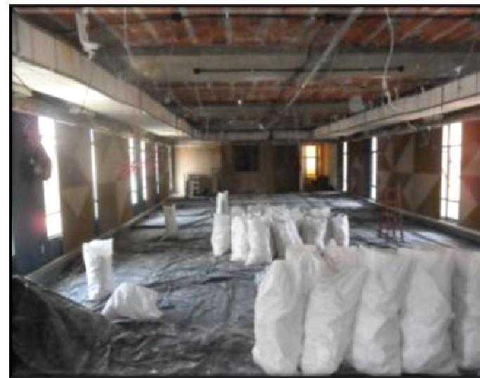
(TR7 CE – Deslocamento Vertical de Chillers) – Demolição do forro de gesso, com transporte e bota fora de material.
