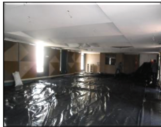
(TR7 CE – Deslocamento Vertical de Chillers) – Proteção do carpete com lona plástica.
