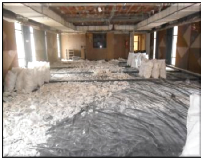
(TR7 CE – Deslocamento Vertical de Chillers) – Demolição do forro de gesso, com transporte e bota fora de material.
